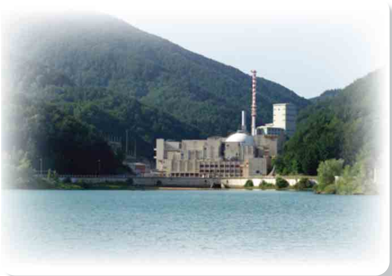
Veduta del Centro del Brasimone, dal lago del Brasimone, con l'edificio del reattore PEC.
