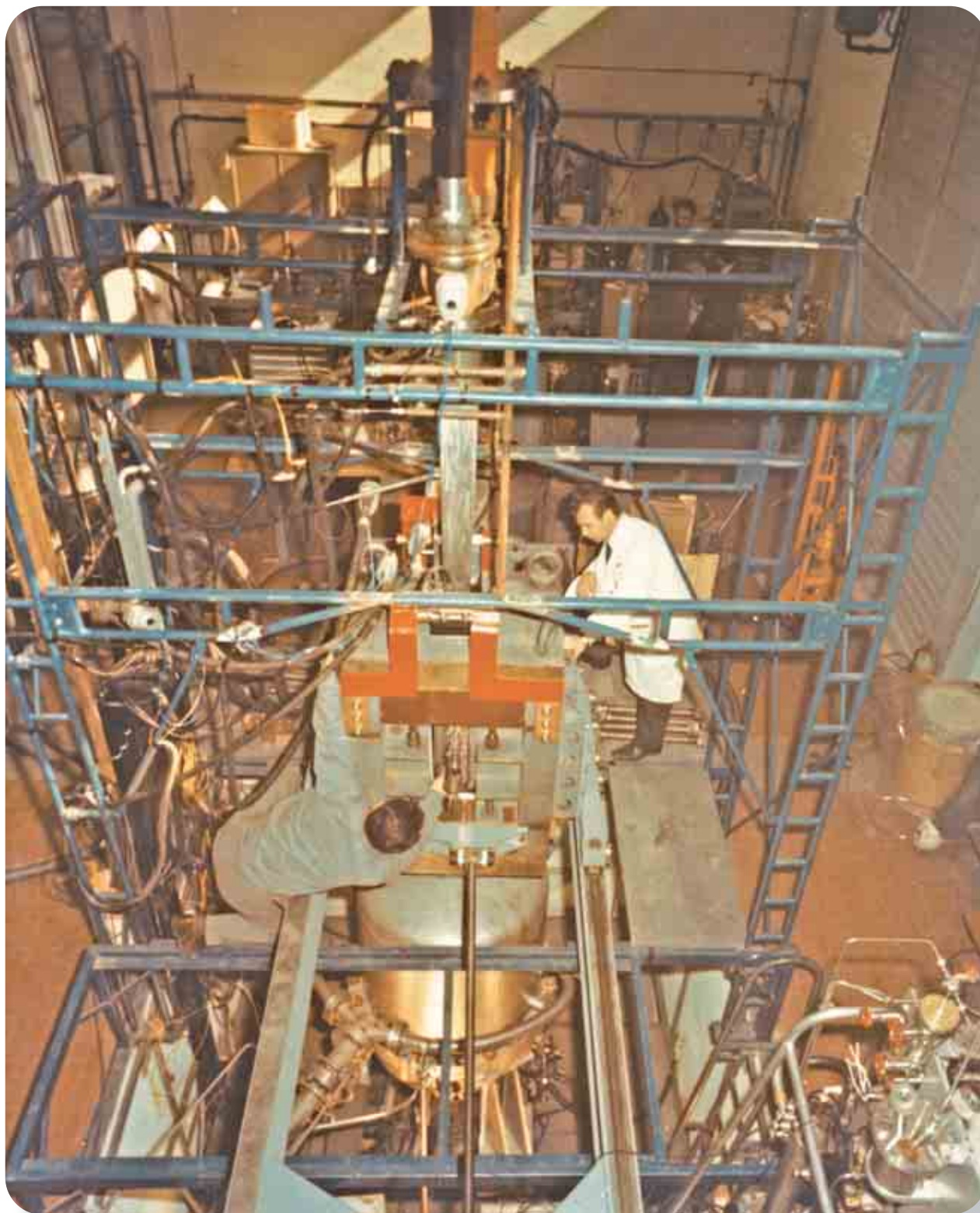
Esperimento di conversione diretta del calore in elettricità per via magnetoplasmodinamica. Experiment on the conversion of heat into electricity by the magnetoplasmodynamic.
