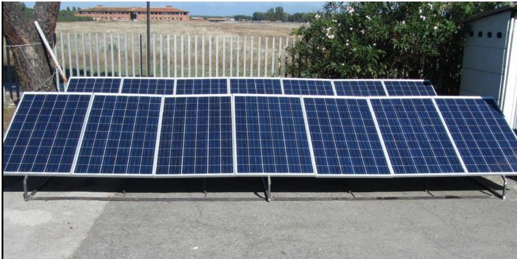
**Figura 3. I pannelli fotovoltaici collegati a formare due stringhe**
