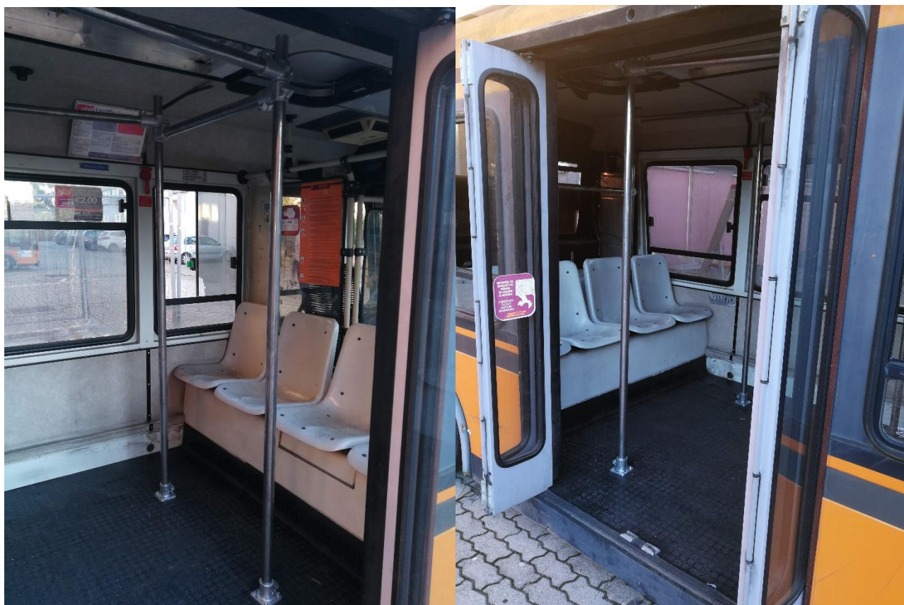
Figura 5 Telaio di rinforzo viste dal lato interno al bus
