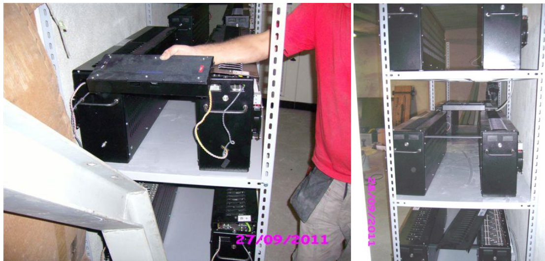
Figura 25. a) Assemblaggio batterie nel locale di Bergamo b) Disposizione finale
