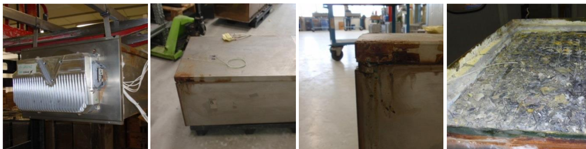
Figura 11. Stato del modulo dopo i test di corto circuito [Errore. Il segnalibro non è definito.]
