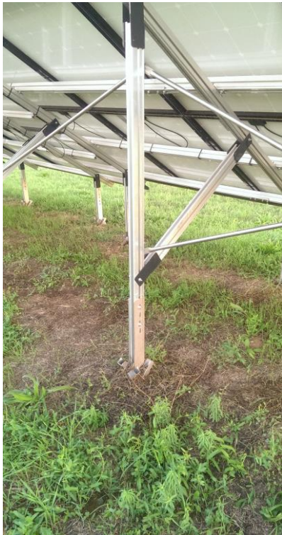
Figura 2. Particolari della struttura di sostegno.
