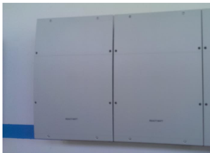
Figura 8. Il Sistema di accumulo ABB-REACT-BATT-AP1 (unità da 4 kWh riferita alla fase L2).
