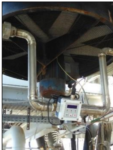
Figura 27. Misuratore di portata condensa ad ultrasuoni
