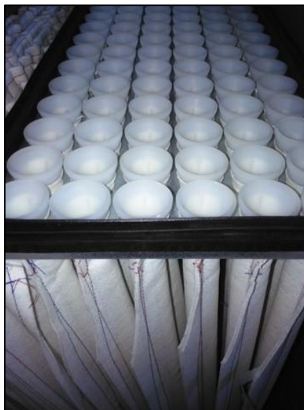
Figura 20. Dettaglio dei cassettei filtranti
