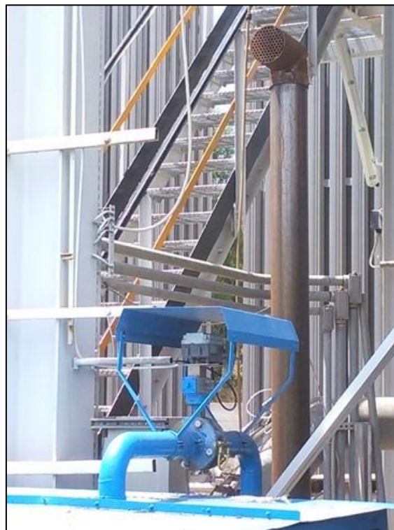
Figura 33. Valvola di riciclo aria (in basso) e vent
