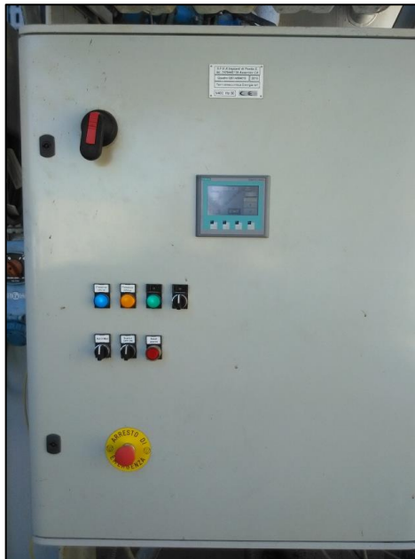
Figura 8. Quadro di controllo Redler.
