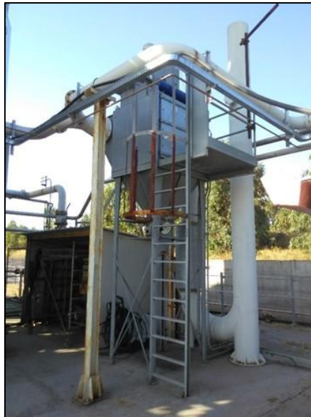
Figura 19. Sistema di depolverazione.
