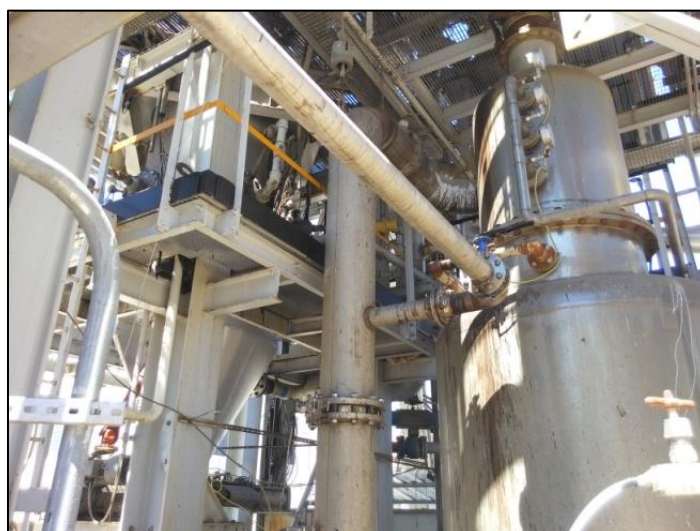
Figura 40. Punto di prelievo del syngas a valle dello scrubber dell'impianto Dimostrativo
