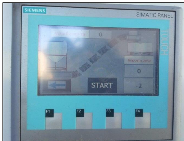
Figura 7. Tastierino fronte quadro di controllo.
