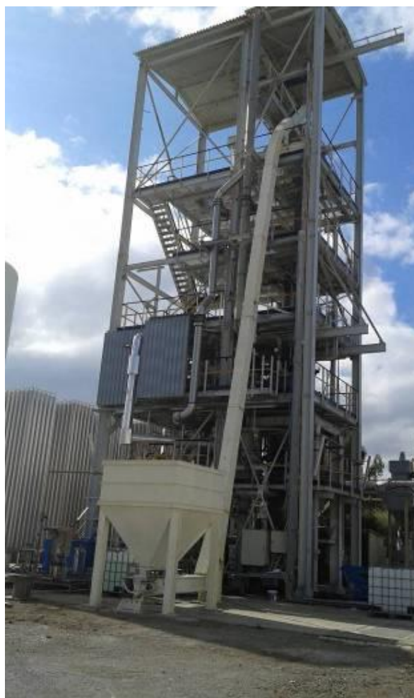
Figura 1. Sistema di caricamento automatico del combustibile "Redler"
