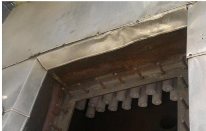
**Figura 2. Dettaglio sul sistema a candele ceramiche per alta temperatura per filtrazione *in-single-vessel* del gas prodotto, integrato nel *freeboard* del reattore di gassificazione ICBFB 1000 kW<sub>t</sub>**
