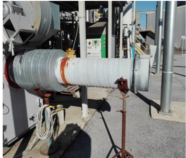
Figura 8. Dettaglio del condotto di scarico della \mu GT.
