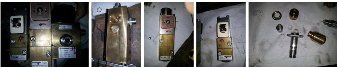
Figura 9. Alcune fasi delle operazioni di manutenzione del blocco valvole di regolazione.
