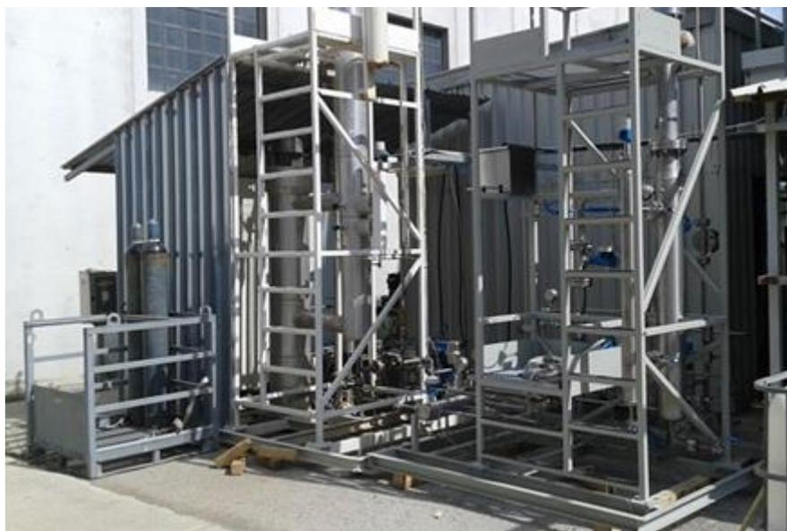
Figura 6. Impianto di assorbimento CO<sub>2</sub> e rigenerazione MEA
