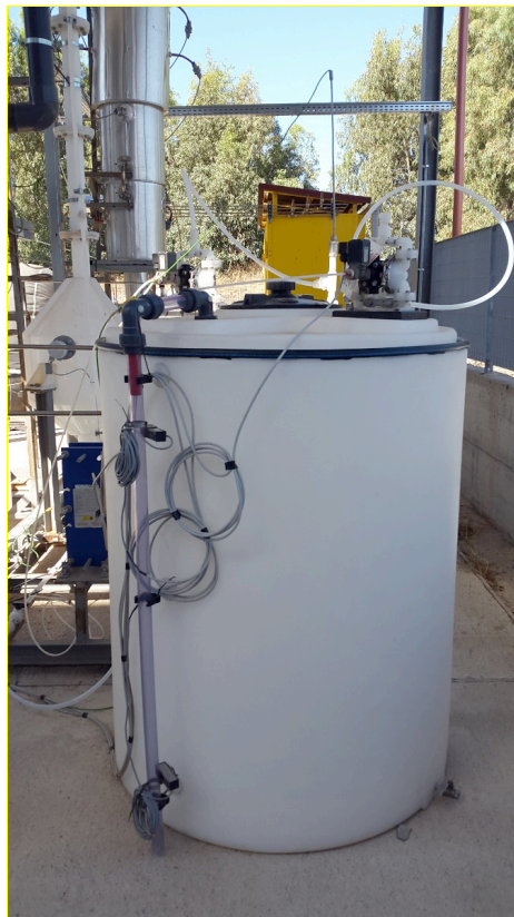
Figure 15 Sezione di stoccaggio acido concentrato
