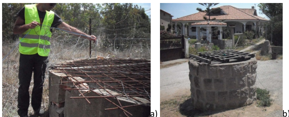
Figura 4. Esempi di pozzi superficiali con elevato diametro: pozzi 52 (a) e 29 (b).
