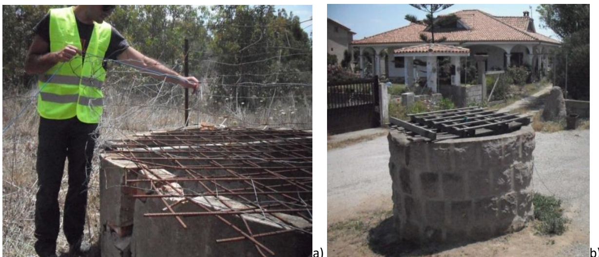
Figura 2. Esempi di pozzi superficiali con elevato diametro: pozzi 52 (a) e 29 (b).
