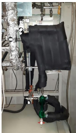
Figura 1.11. Zona di preraffreddamento e trappola di condensazione
