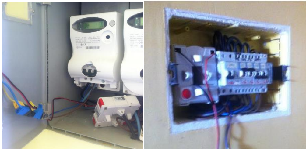
Figura 132: particolare delle fasi di installazione degli strumenti di misura a valle del contatore Selis e a valle dell'interruttore di alimentazione dello scaldabagno.
