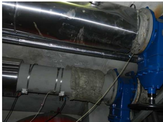
Figura 2. 19 - Installazione strumenti di misura
