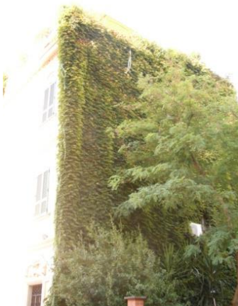
Figura 10. Unità esterna del condizionamento
