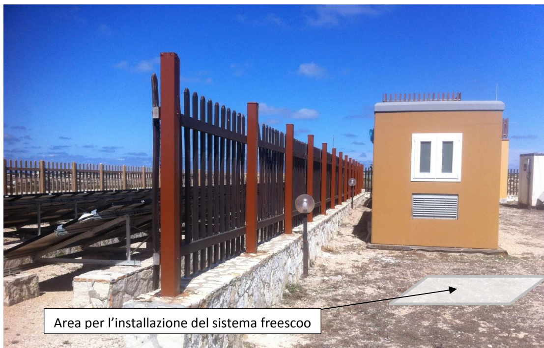
Figura 157. Vista dell'impianto fotovoltaico e del container dove sono installate le apparecchiature da utilizzare durante le sperimentazioni.
