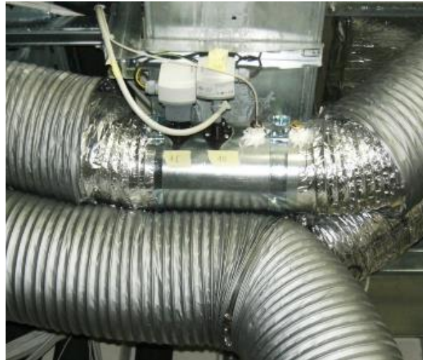
Figura 5. Sensori di temperatura, umidità relativa, concentrazione di CO 2 e composti organici volatili su canale dell'aria in impianto di ventilazione meccanica (canale principale di aria di ripresa).
