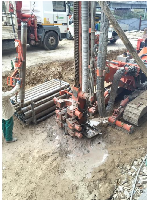
Figura 85. Fotografia dell'infilaggio di una sonda nel terreno.
