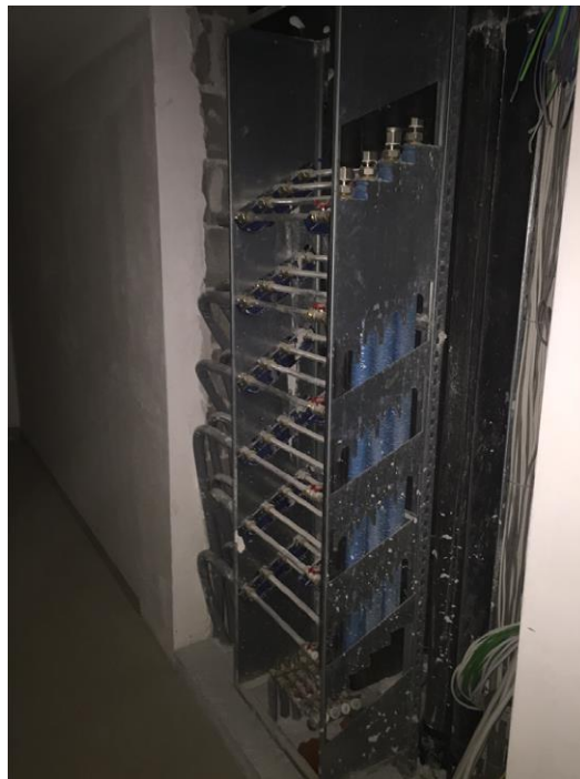
Figura 88. Fotografia del cenro satellite con le derivazioni per le unità
