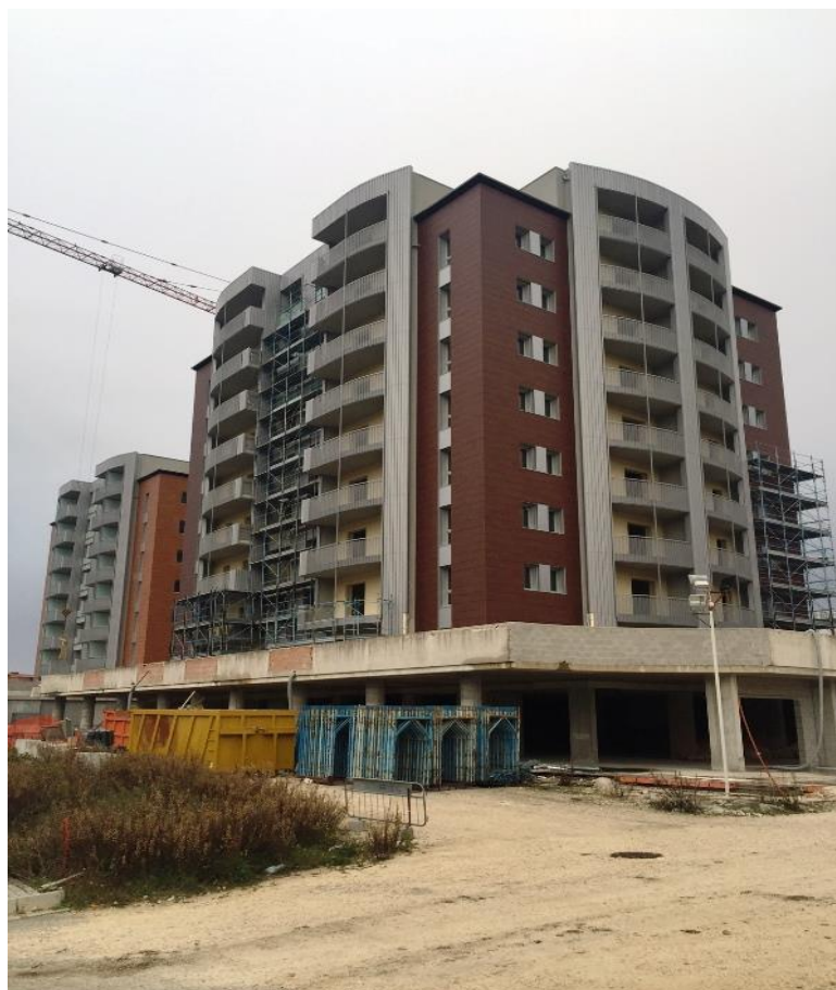
Figura 76. Stato dei lavori a marzo 2016
