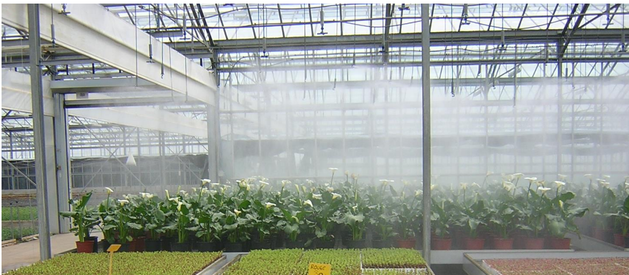
Figura 1.2.3: Raffrescamento mediante fog system.
