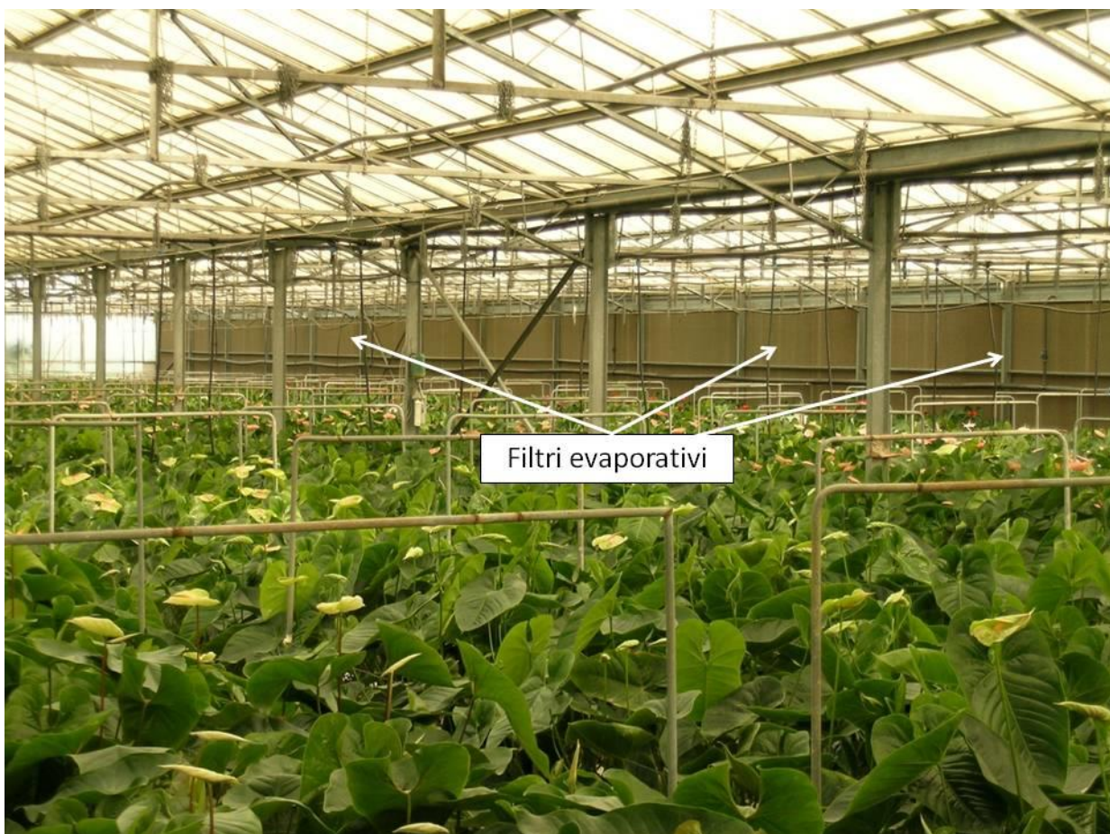
Figura 1.2.1: Filtri evaporativi nel sistema di raffrescamento.
