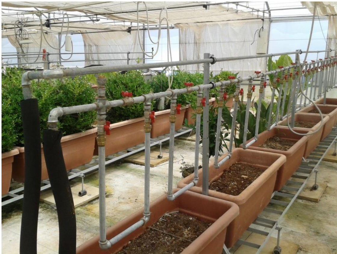
Figura 2.2.12: Linea di adduzione acqua fredda.
