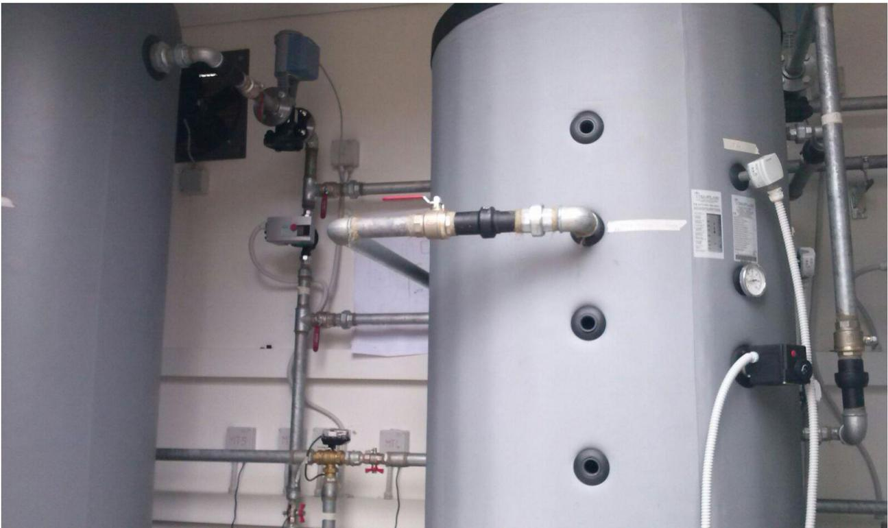
Figura 123: dettaglio accumulo ACS in cabina 2- connessione idrauliche, resistenza ausiliaria, sonde attive di temperatura, valvole, circolatore (P2), valvola a tre vie (Vt1)
