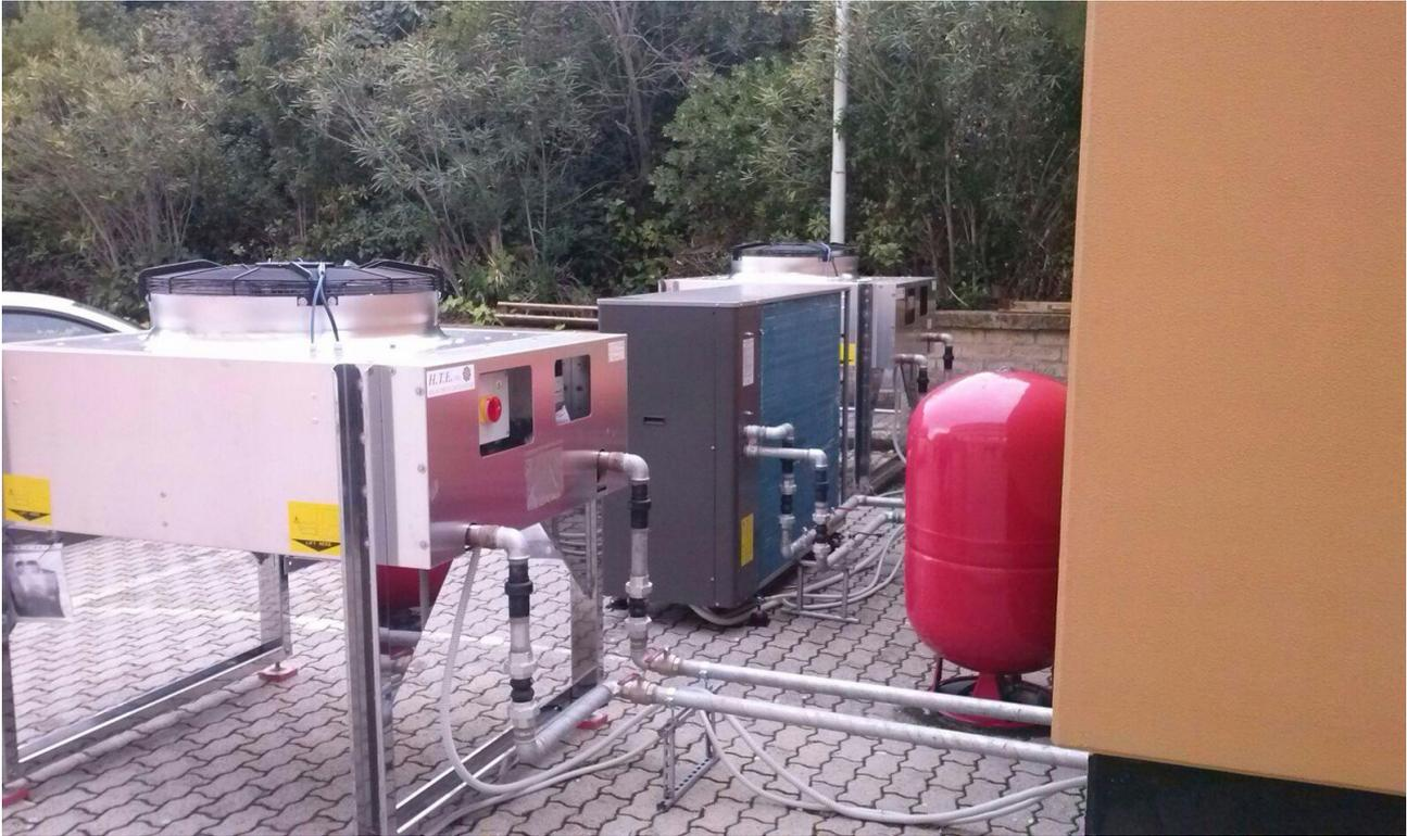
Figura 122: connessione unità esterne: due drycooler e pmpa di calore
