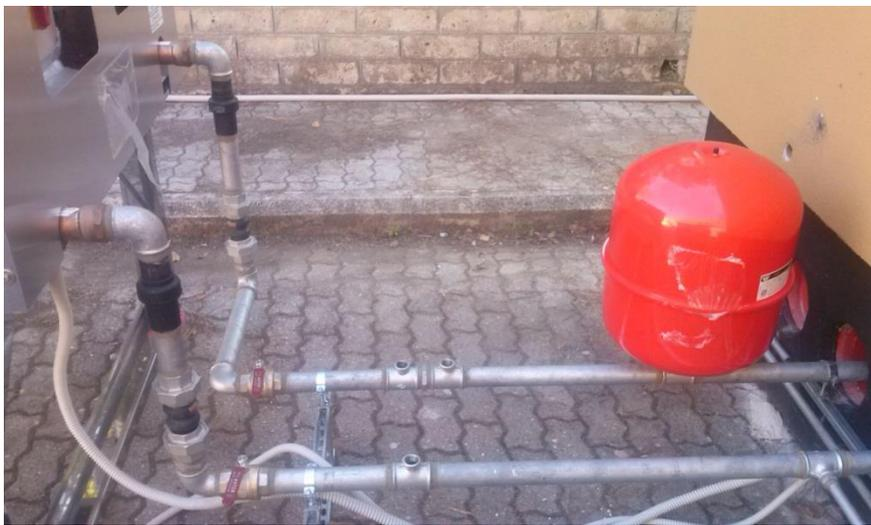
Figura 121: circuito idraulico dry cooler per ACS – dettaglio giunti dielettrici e smorzatori
