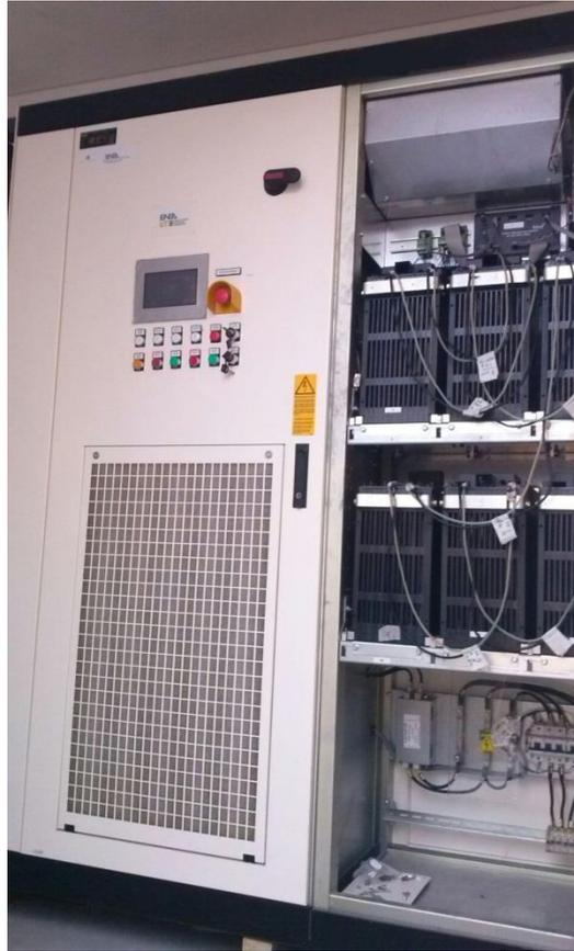
Figura 124: Inverter bidirezionale 30 kVA installato in cabina 1 - sei batterie a Litio Kokam da 16 kWh, 70 Ah
