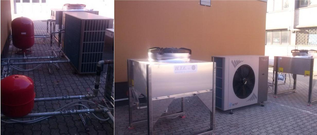
Figura 120: Dettagli vasi di espansione e unità esterne (dry cooler e pompa di calore ) durante la fase di installazione
