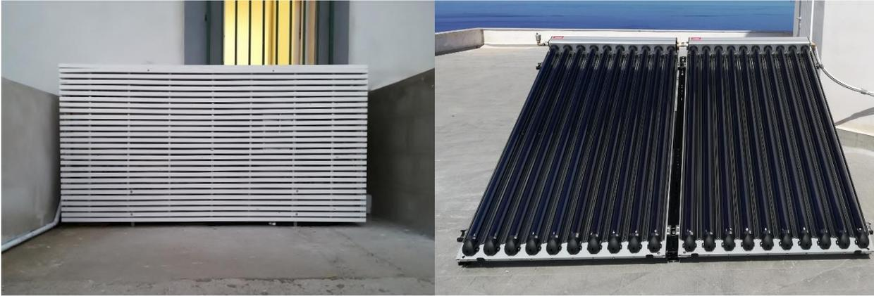
Figura 164: foto installazione unità esterna freescoo facade affiancata alla parete e collettore solare sul tetto dell'edificio
