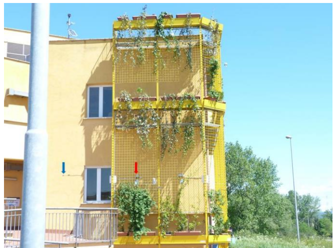
Figura 34 - A sinistra: temperature medie della parete SO nel mese di aprile; i colori sono da interpretare come nelle precedenti figure. A destra: fotografia del lato SO scattata il 19 aprile alle ore 12.40. Le frecce indicano la posizione dei sensori di temperatura della parete.
