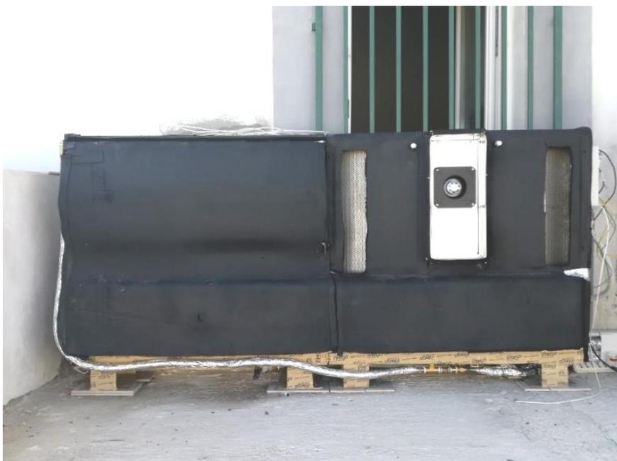
**Figura 174** Sistema freescool facade durante l'installazione alla sede ENEA al faro di Grecale a Lampedusa
