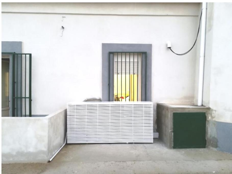
**Figura 175 Sistema freesco facade completo di struttura di rivestimento**
