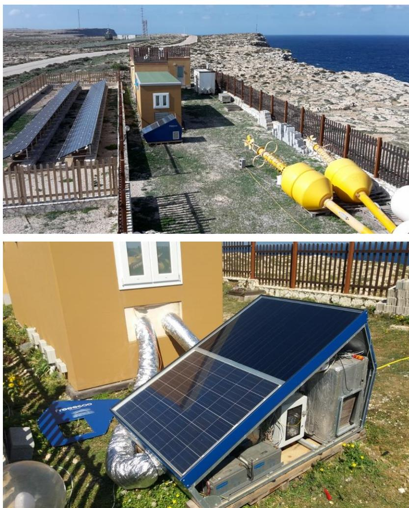
Figura 134 Foto del sistema *freescoo* stand-alone installato presso il centro ricerche ENEA a Lampedusa
