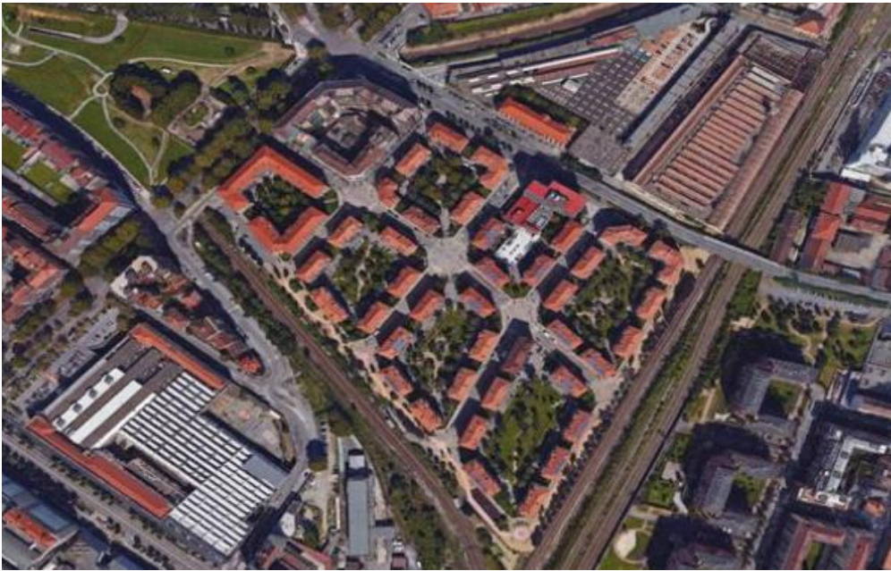
Figura 151 – Vista aerea della rete di teleriscaldamento di Torino (Arquata)
