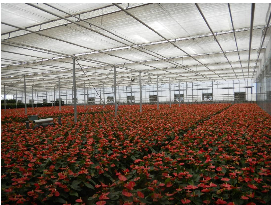
Figura 13: Schermo termico interno in una serra floricola in Puglia.
