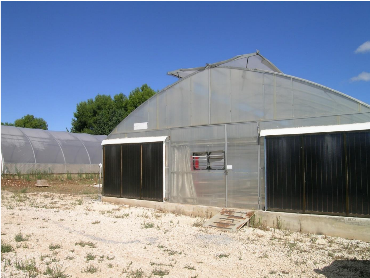
Figura 18: Pannelli solati termici installati sulla testata sud di una serra ed utilizzati a servizio di un sistema di riscaldamento dell'area di coltivazione a bassa entalpia.
