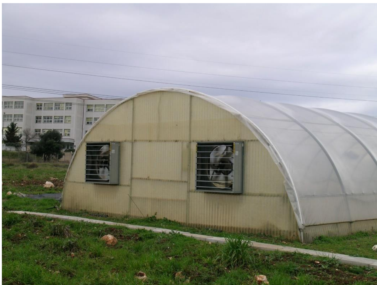
Figura 23: Ventilatori utilizzati per la ventilazione forzata di una serra.
