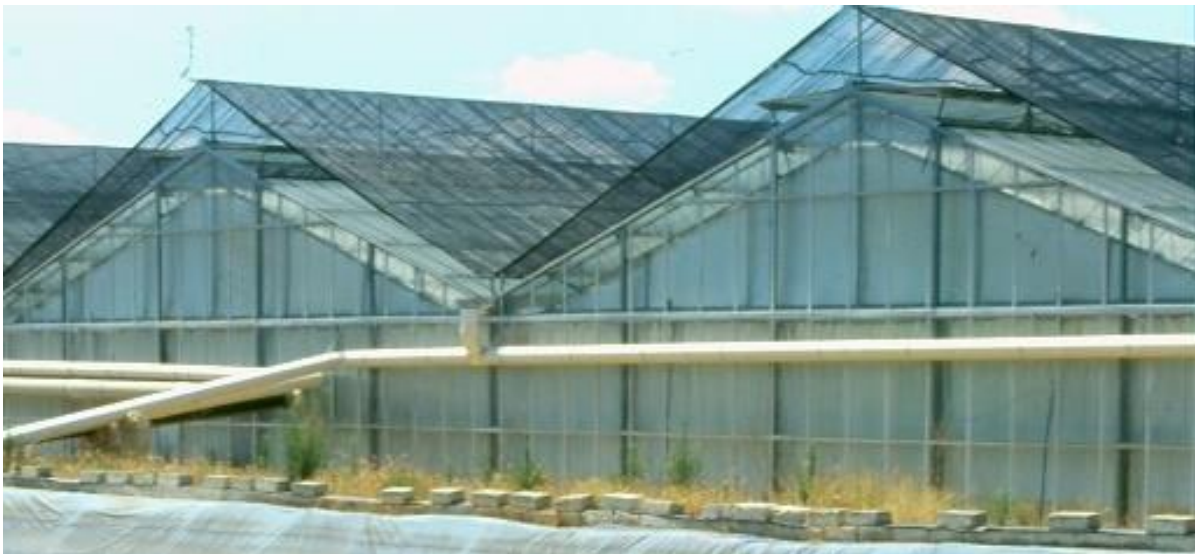
Figura 21: Ombreggiamento di una serra ottenuto con reti posizionate esternamente.
