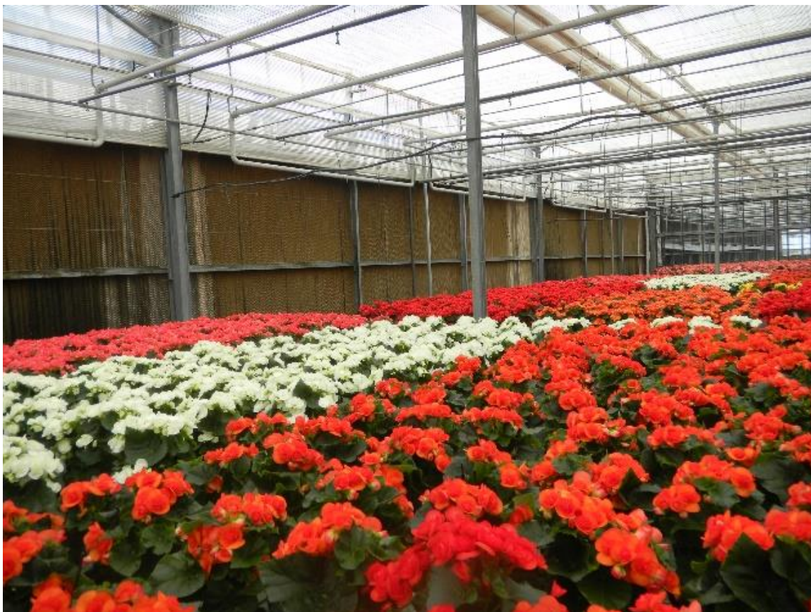
Figura 24: Sistema a filtri evaporativi: pannelli
