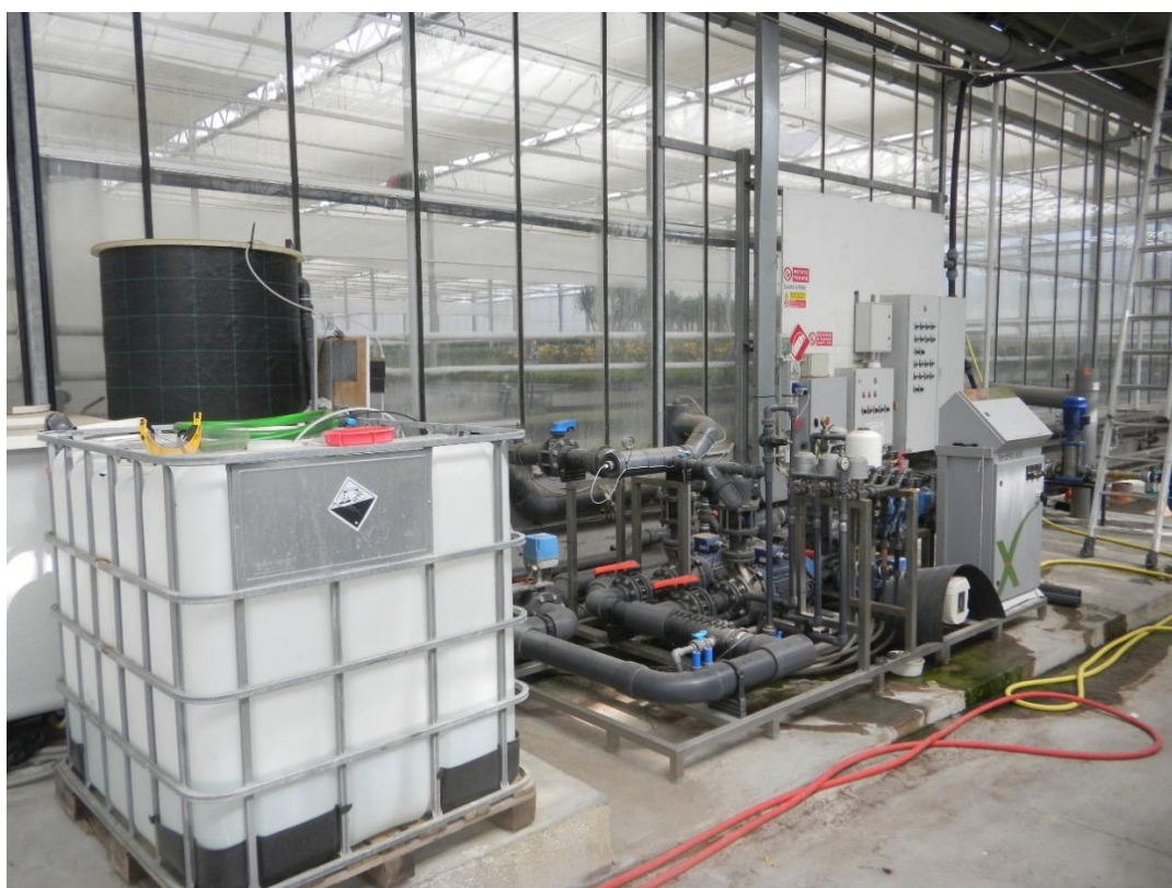
Figura 10: Impianto di fertirrigazione in una serra floricola in Puglia.
