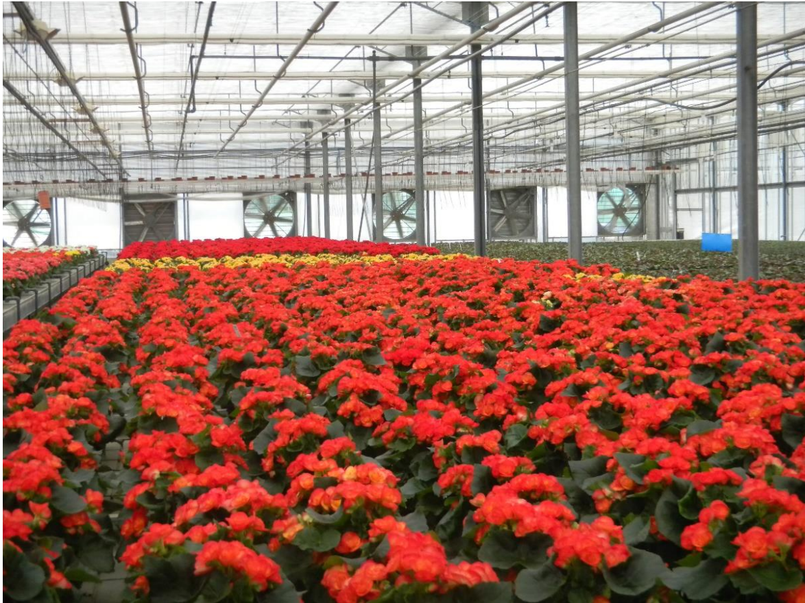
Figura 8: Interno di una serra floricola in Puglia: ventilatori dell'impianto di raffrescamento accoppiati con filtri evaporativi, presenti sul lato opposto della serra.
