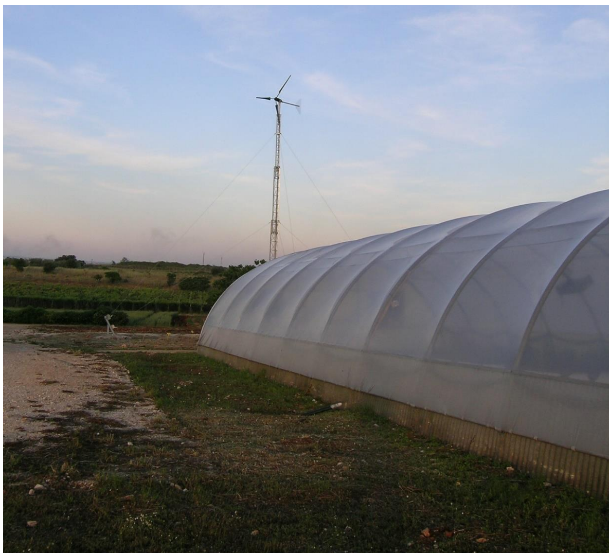
Figura 16: Generatore eolico di piccola taglia a servizio delle utenze elettriche in insediamento serricolo.
