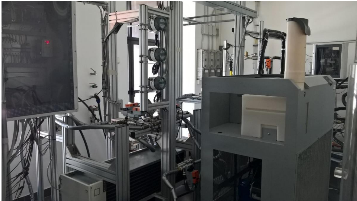
Figura 2. Impianto prova accumulo freddo presso il CR Enea Portici.
