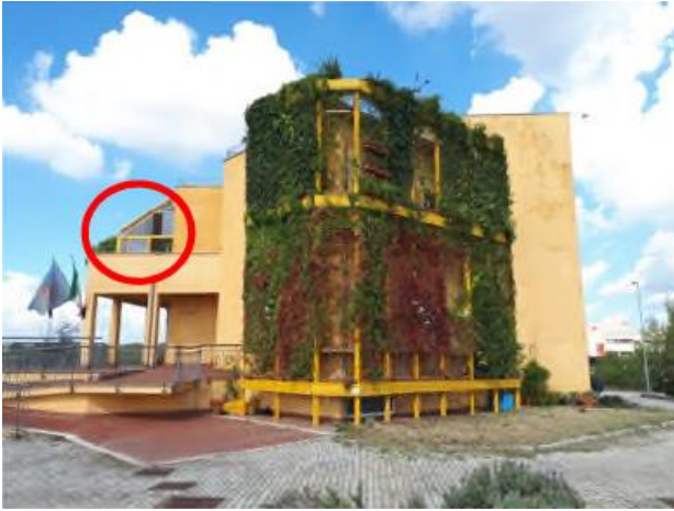
Figura 87 - Lato sud ovest
