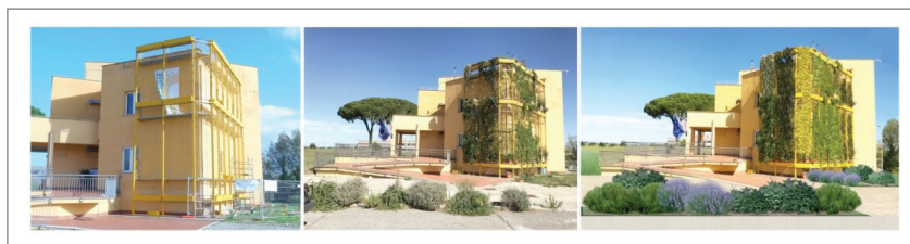
Fig. 1 Prototipo della parete-verde sull'edificio dimostrativo del Centro Ricerche ENEA Casaccia
