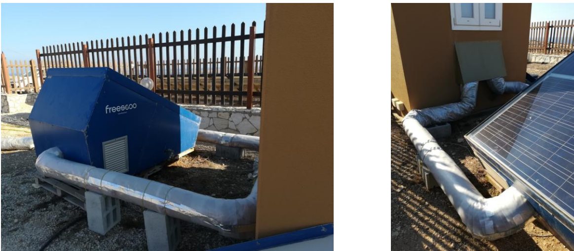
Figura 48 Foto delle canalizzazioni dell’aria dopo il ripristino
