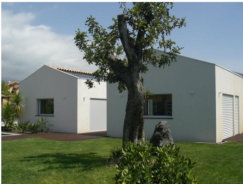
Figura 1. Vista esterna dell'edificio oggetto di studio.
