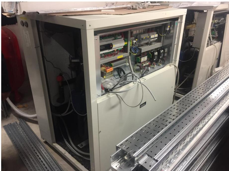
Figura 22. Pompa di calore installata nell'edificio.
