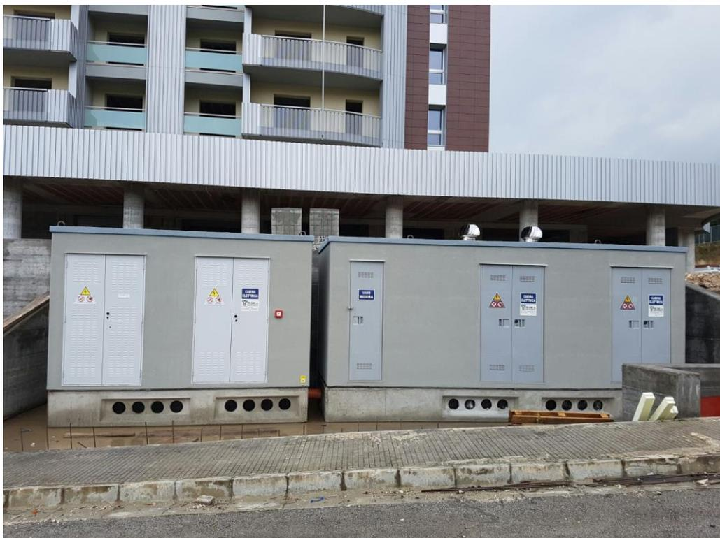
**Figura 37. Particolare delle cabine. A sinistra vano trasformatore e quadro di media tensione di proprietà. A destra vano misura e vano di consegna del distributore.**
