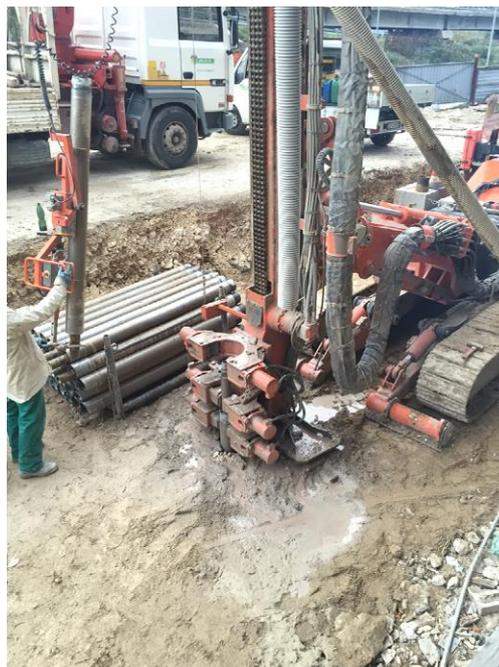
Figura 25. Fotografia dell'infilaggio di una sonda nel terreno.
