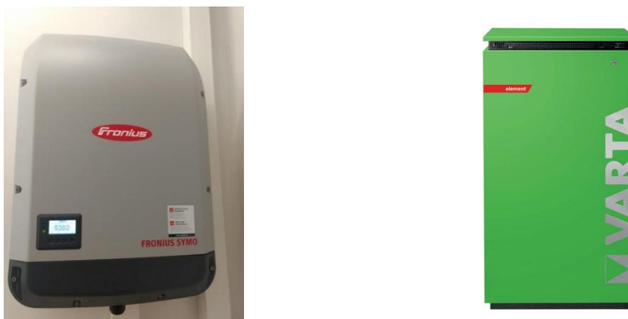
**Figura 108. Inverter dell'impianto fotovoltaico (a sinistra) e batteria d'accumulo fotovoltaico (a destra) presenti nel laboratorio domotico.**
