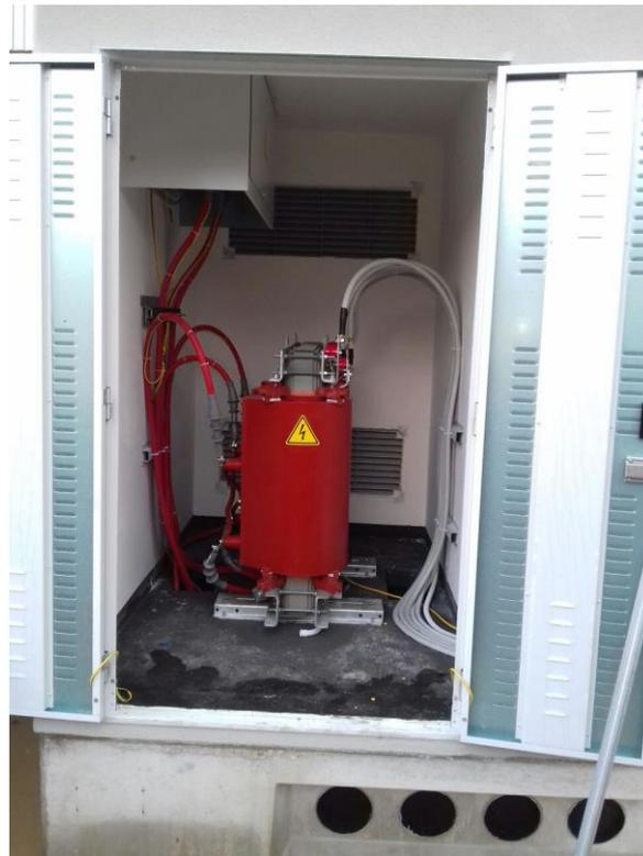
Figura 38. Particolare del vano conil trasformatore da 400 kVA.
