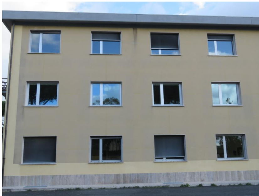
Figura 14 - Facciata dell'edificio con i nuovi serramenti installati al piano 1.
