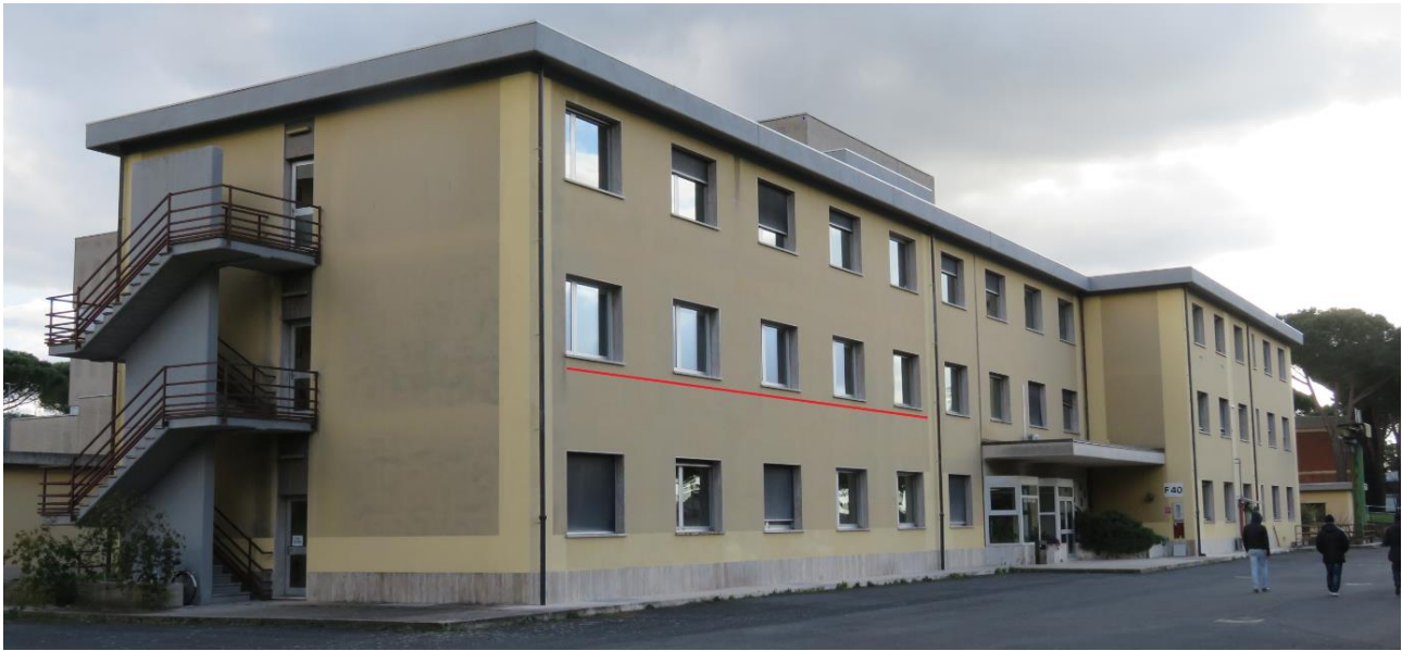
Figura 10 - L'edificio F40 di Casaccia, oggetto dell'intervento
