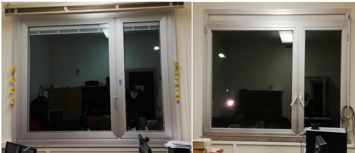
Figura 11 - Nuovo serramento installato, sinistra, e vecchio serramento
