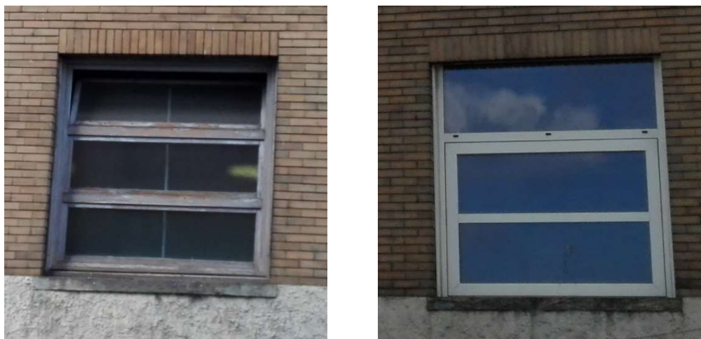
Figura 4.8. Particolare infissi (in legno e vetro singolo a sinistra, in alluminio e vetro doppio a destra).
