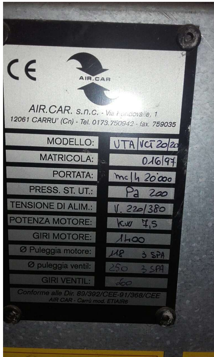
Figura C.7. Caratteristiche tecniche UTA palestra esterna 16
