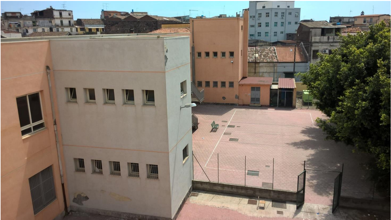
Figura 123: Vista del cortile interno della scuola
