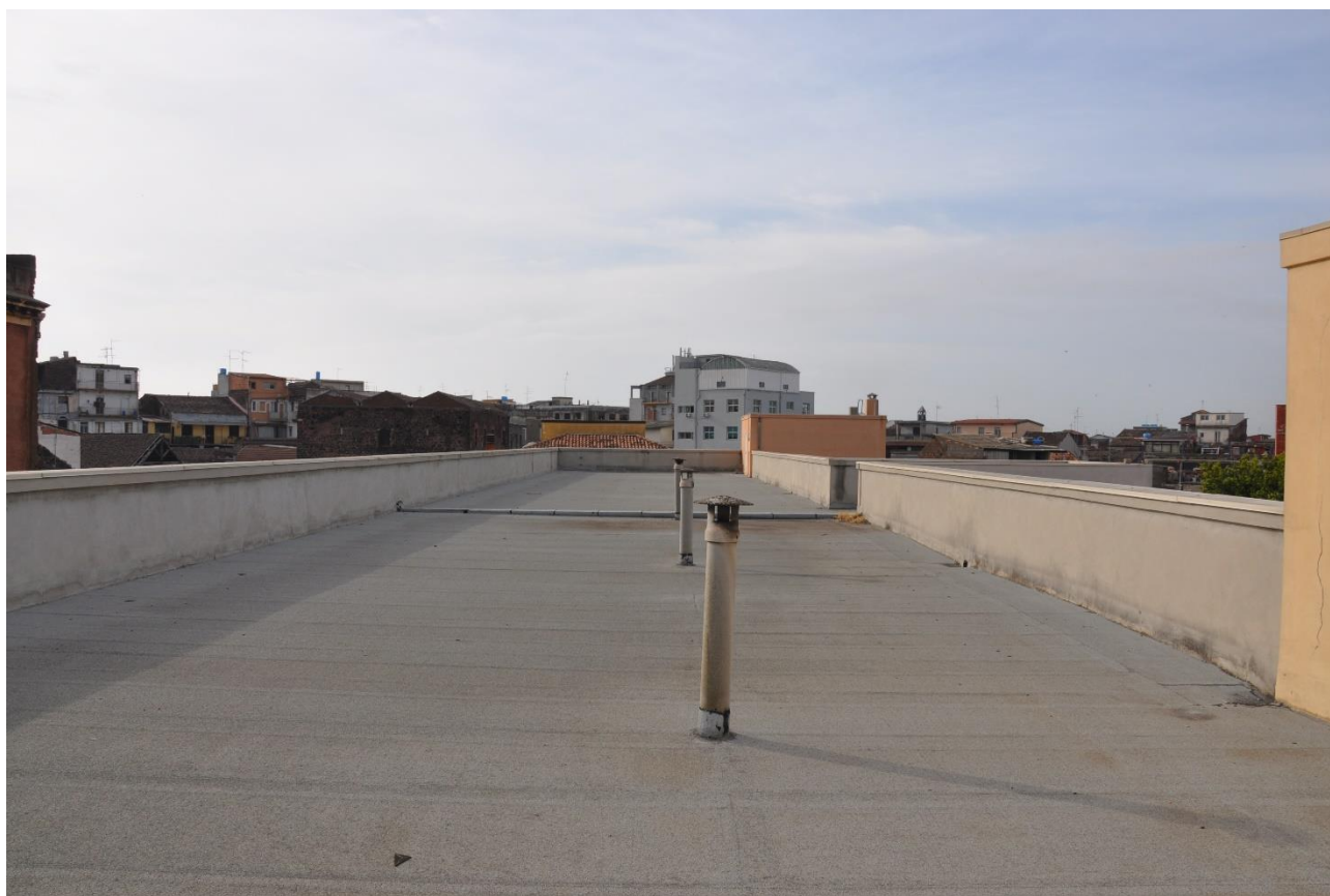
Figura 122: Vista di un lato della copertura a terrazzo
