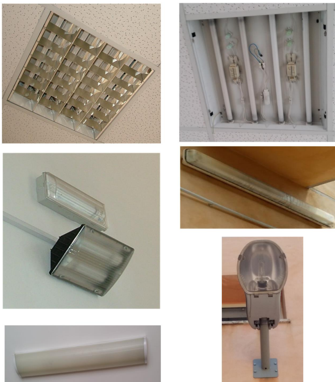
Figura 182: Corpi illuminanti dell'edificio. Lampade a fluorescenza, a basso consumo e a ioduri metallici.
