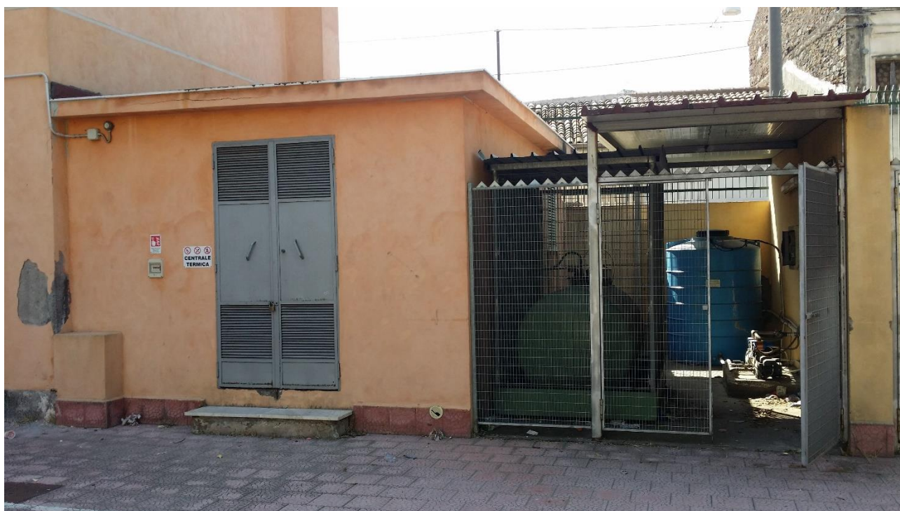
Figura 155: La centrale termica e l'autoclave
