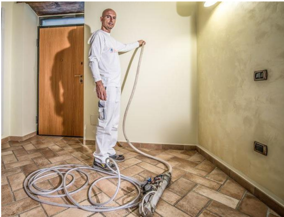
Figura 124: Inserimento della schiuma isolante
