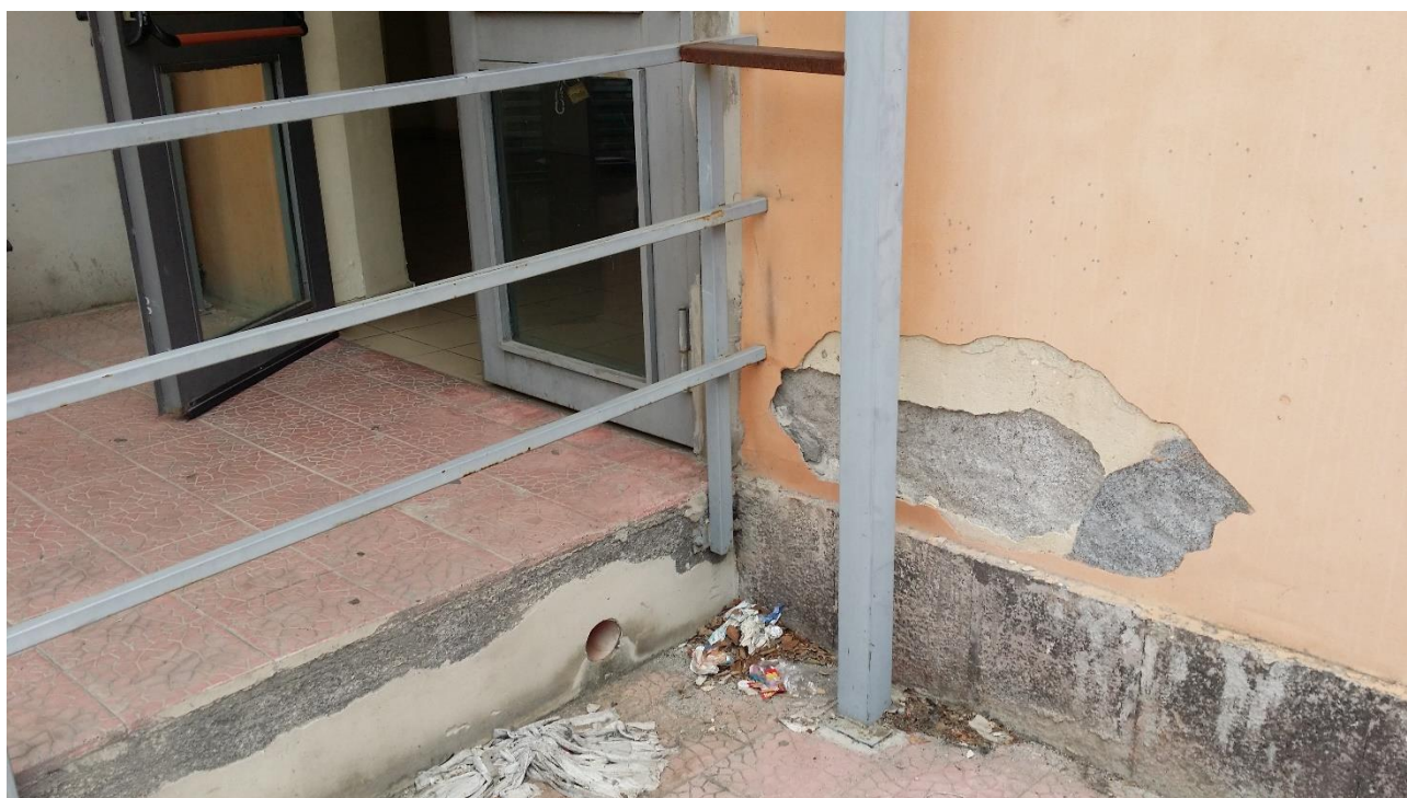
Figura 118: Stato di conservazione esterno
