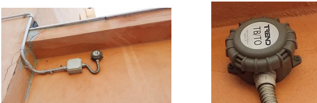
Figura 21: Sonda Master esterna
