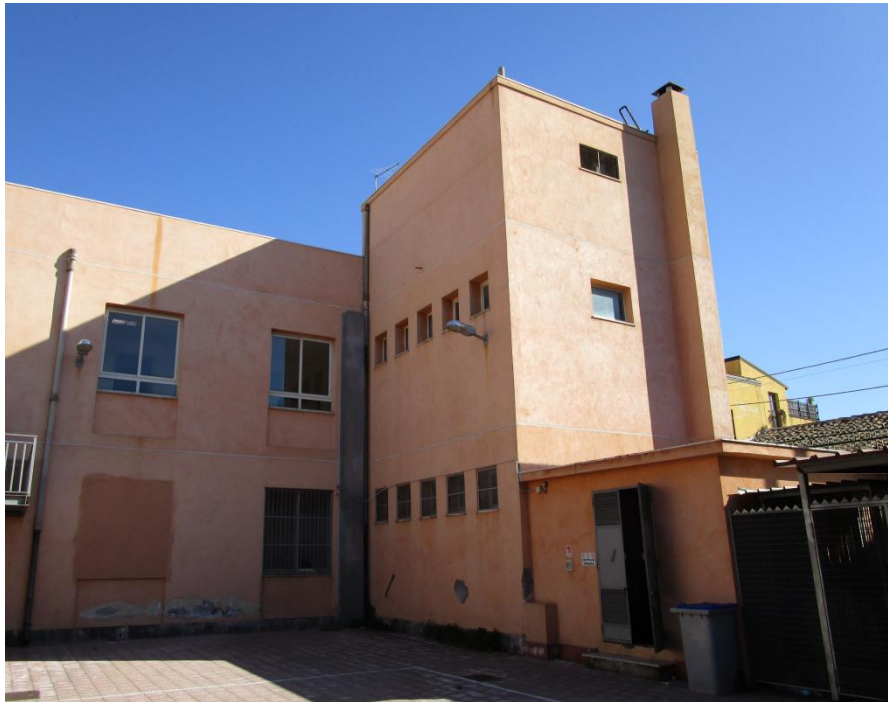
Figura 7: Vista laterale del cortile interno con la centrale termica e serbatoi acqua
