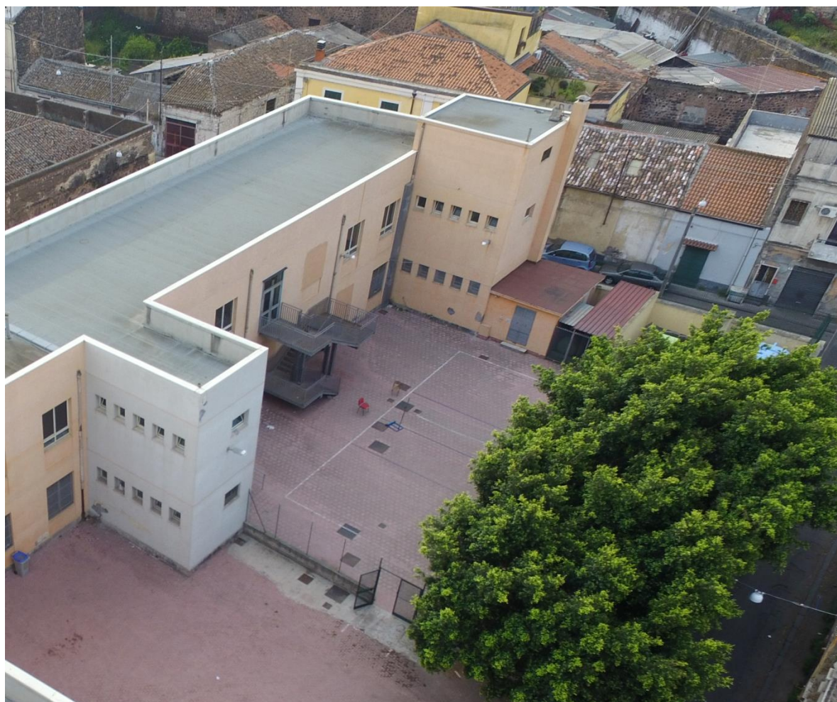
Figura 156: Centrale termica in relazione all'edificio
