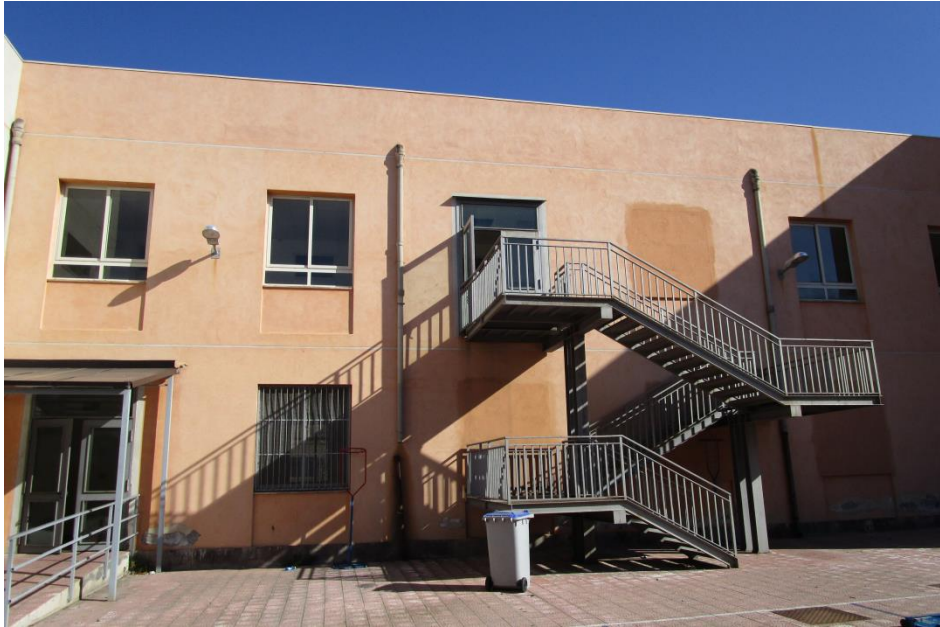
Figura 5: Cortile interno della scuola L. Tempesta
