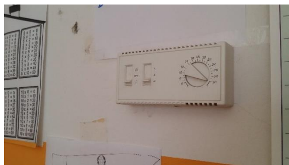
Figura 23: Termostato ambiente
