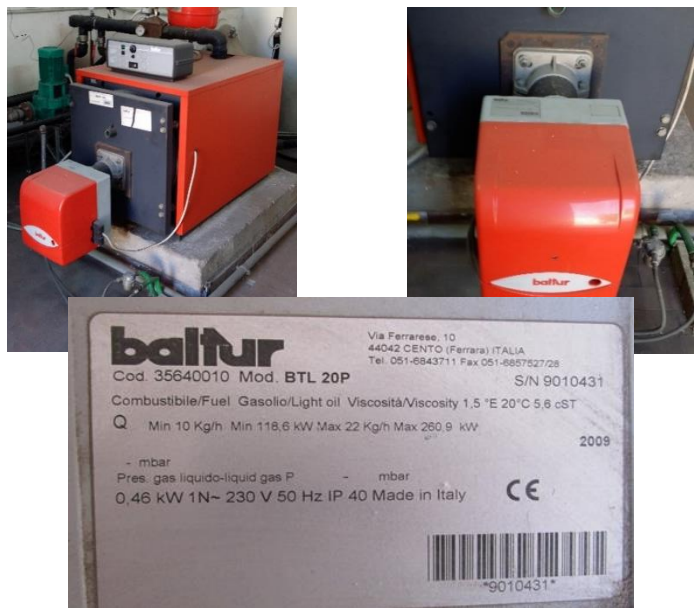
Figura 14: Caldaia e dati di Targa
