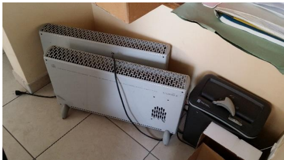
Figura 16: Termoconvettori elettrici
