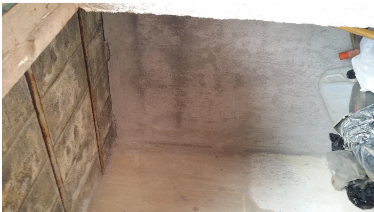
Figura 119: Stato delle murature esterna
