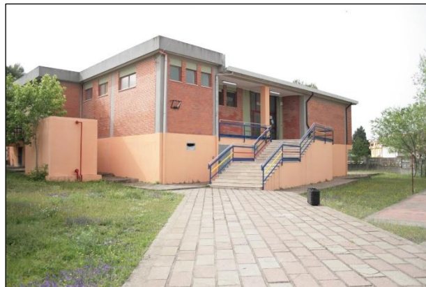
Figura 5.16. Scuola primaria Is Meis: prospetto principale.
