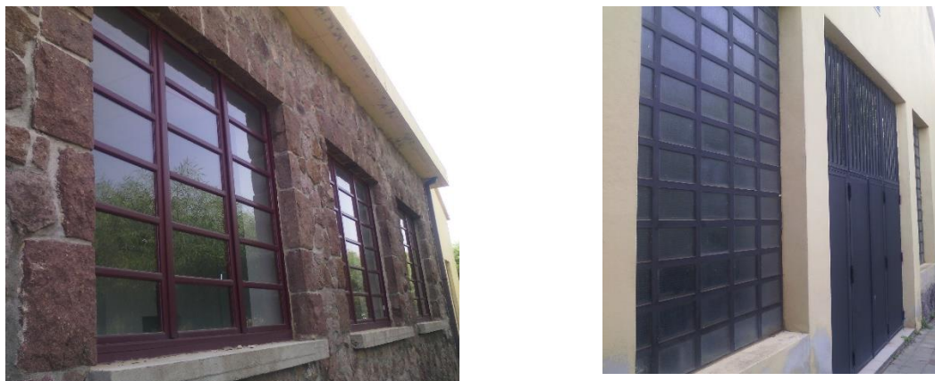
Foto 6.4. Superfici vetrate e portone
