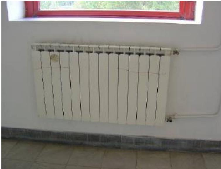
**Figura 35. Terminale di scambio termico privo di regolazione locale**
