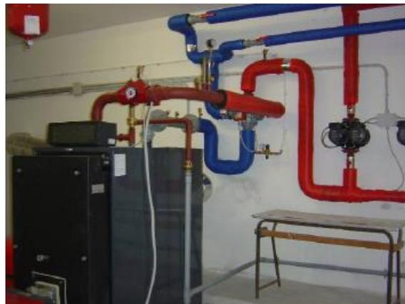
Figura 33. Generatore per produzione acqua calda per riscaldamento in centrale termica
