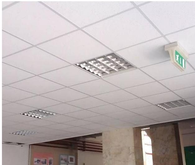
**Figura 29. Particolare del sistema di illuminazione artificiale e di quella di emergenza**
