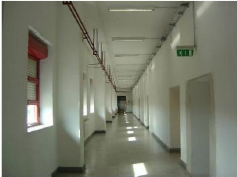
**Figura 34. La dorsale di distribuzione del fluido termovettore**
