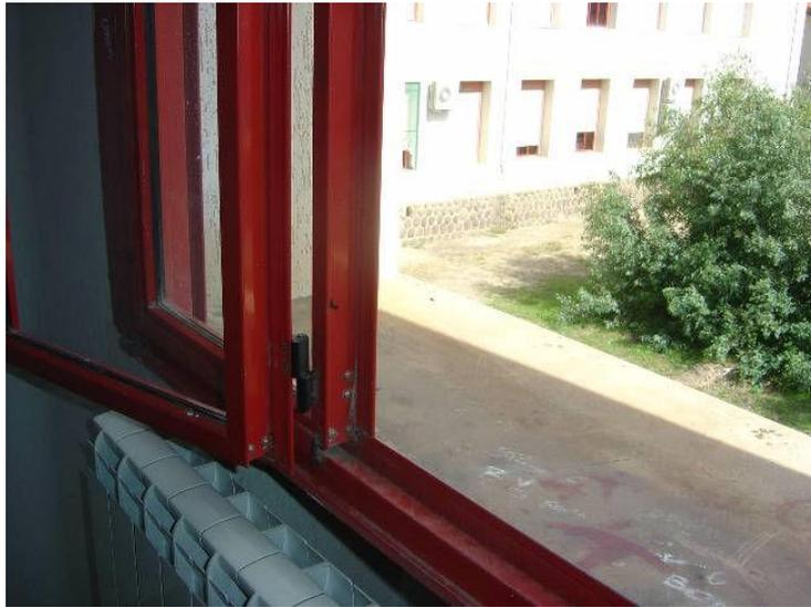
**Figura 25. Profilo di un serramento tipo**
