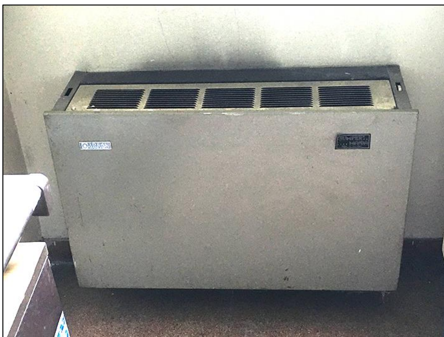
Figura 4.12. Ventilconvettorie originario.
