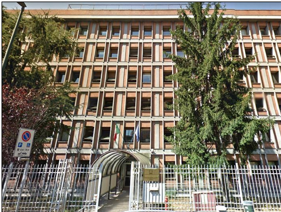
Figura 4.5. Dettaglio di facciata.
