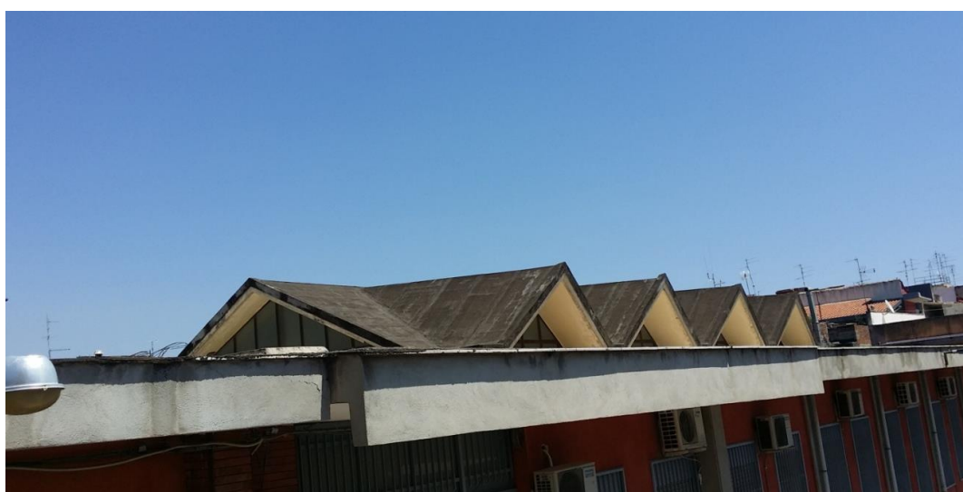
Figura 60. Copertura esistente del lucernario sul corridoio
