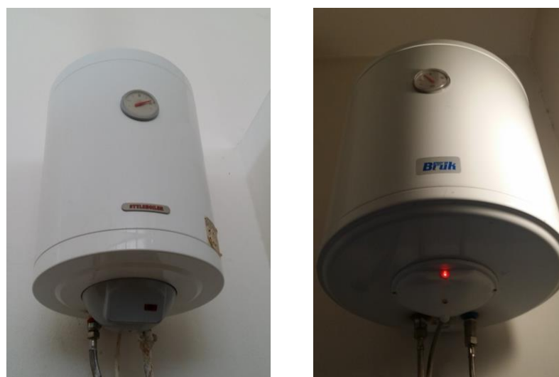
Figura 17. Scaldacqua elettrici
