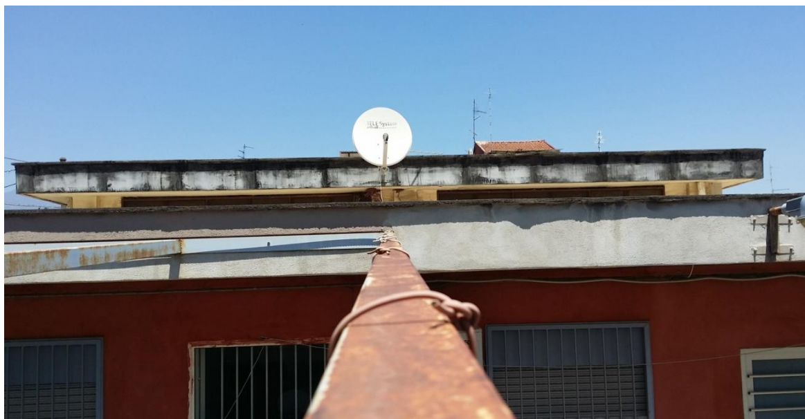
Figura 13. Copertura del lucernario sul disimpegno
