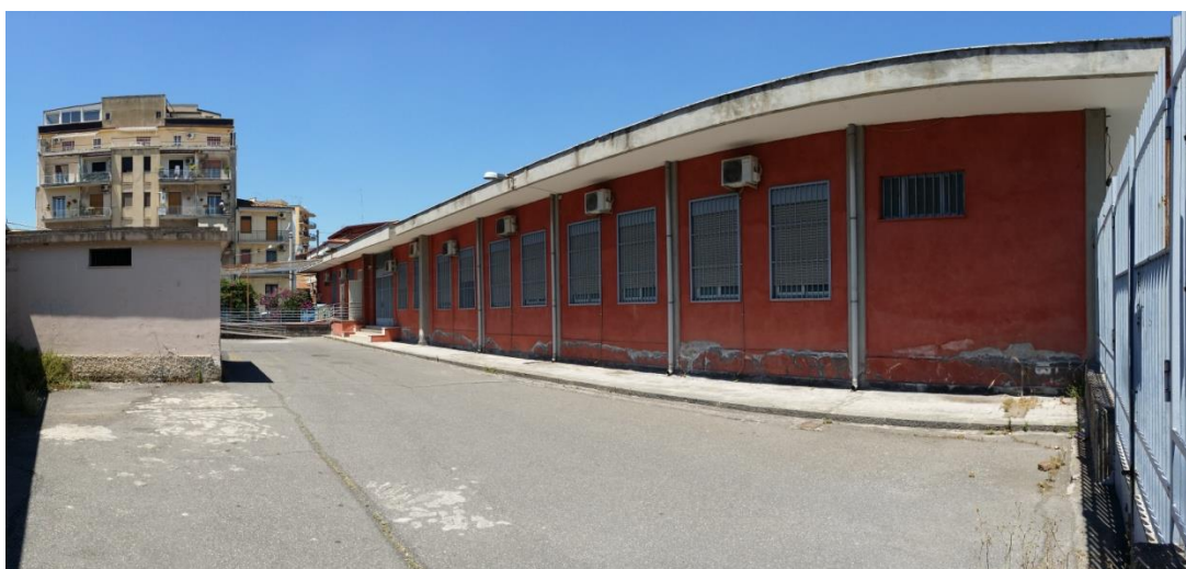
Figura 6. Lato sud dell'edificio che si affaccia sul cortile interno
