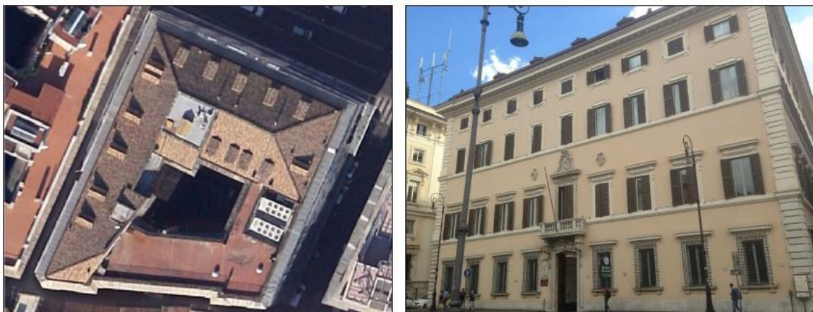
Fig. 3: Vista del perimetro esterno di Palazzo Baleani
