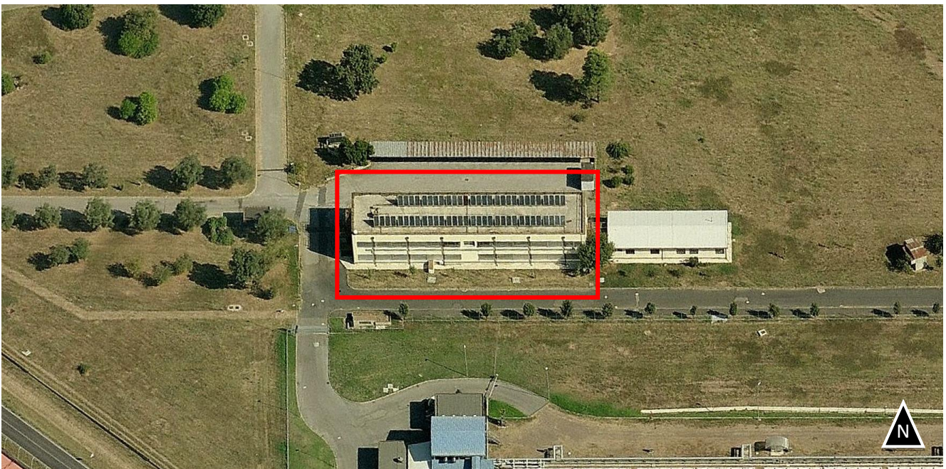
Figura 1 Edificio F51 del Centro Ricerche Casaccia dell'ENEA – fonte Bing Maps.
