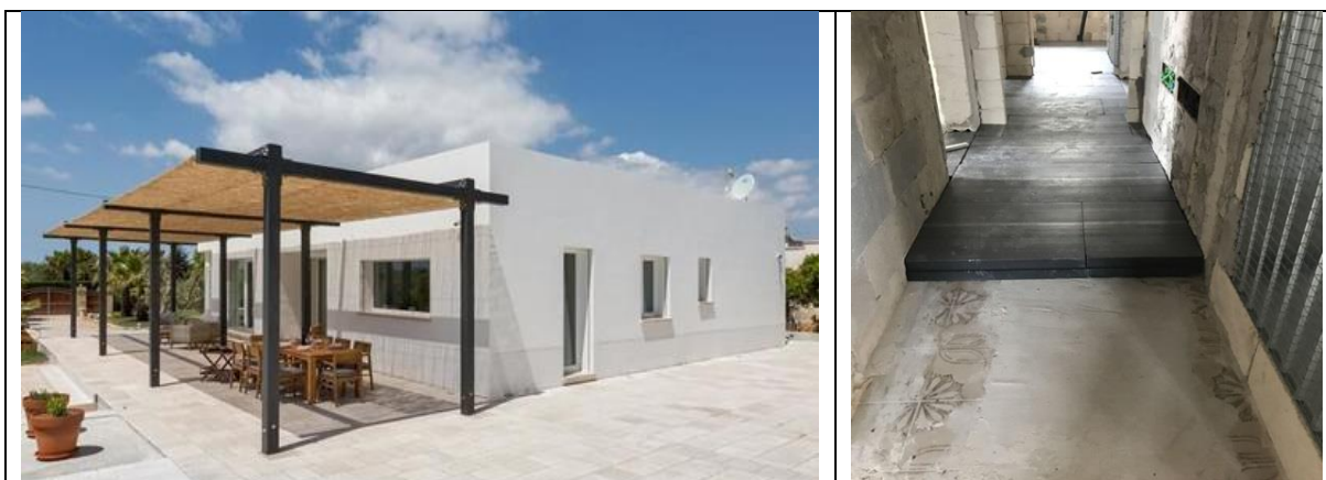
Figura 15. Edifici monofamiliare a uso turistico in Salento e soluzione di isolamento del solaio contro terra
