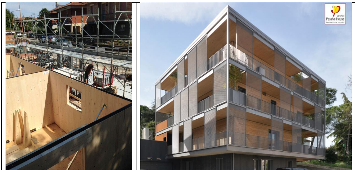
Figura 18. La "Fiorita" a Cesena: demolizione e ricostruzione di edificio NZEB con tecnologia X-Lam
