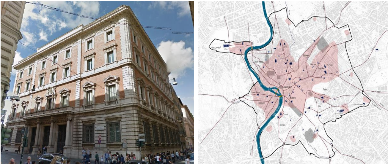
Figura 8.1 – Vista dell'edificio e ubicazione
