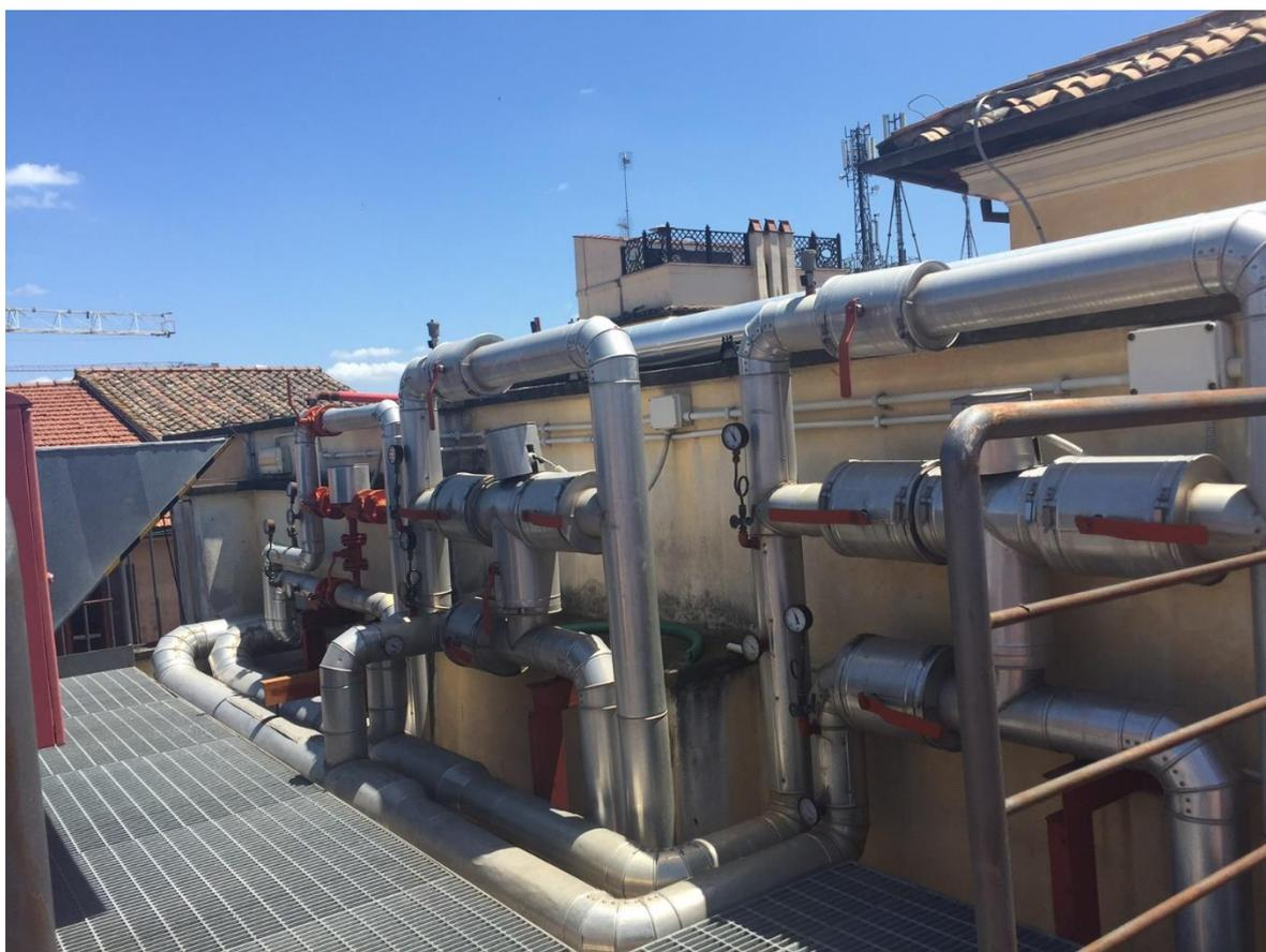
**Figura 11: Pompe e le valvole di regolazione della centrale**
