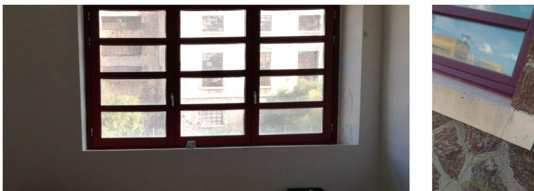
Figura 16. Chiusure finestrate, particolare dove si infila l'acqua
