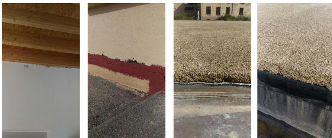
**Figura 15. Particolari del degrado delle chiusure orizzontali**
