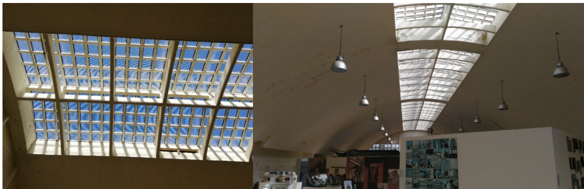
Figura 22. Copertura vetrata della lampisteria vista interna
