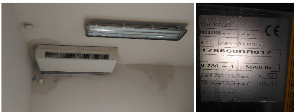
Figura 35. Ventilconvettore dell'ufficio e del deposito (VC_tipo_1)
