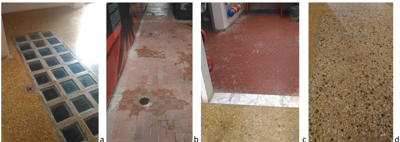
Figura 14. Pavimentazioni originali: a) pavimentazione del BAR con punti luce del locale seminterrati; b) pavimento delle zone espositive laterali (Museo 2, Museo 3) utilizzate originariamente come docce; c) sala Caschi; d) marmettoni della ex lampisteria
