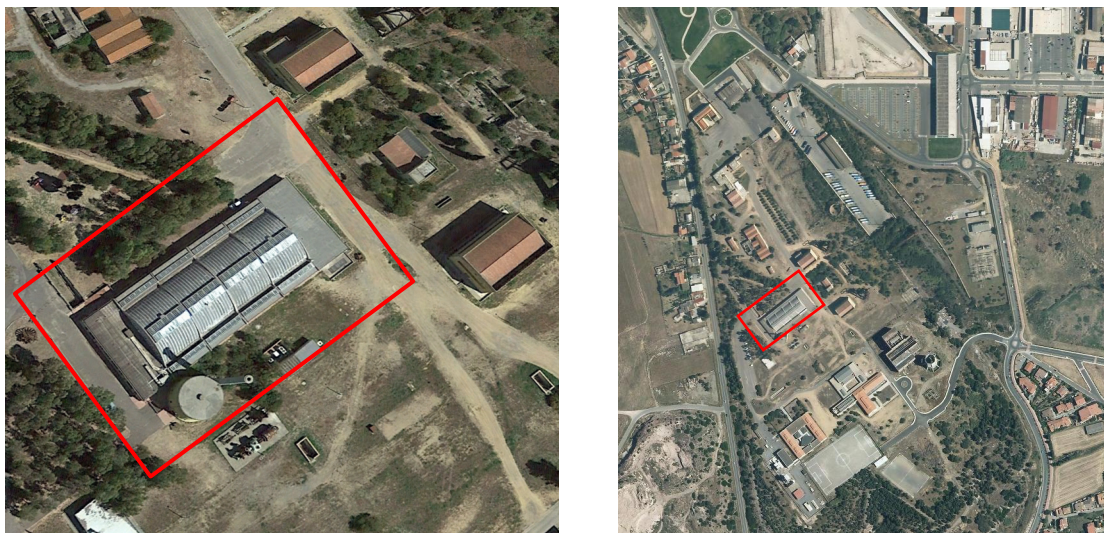
Figura 1. Edificio in oggetto e complesso della Grande miniera di Serbariu (Ortofoto 2013 RAS)
