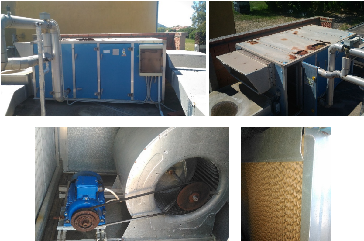
Figura 29. UTA_1 a servizio della zona commerciale alimentata dalla HP_1
