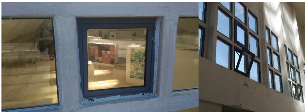
Figura 17. Telaio apribile a vasistas della vetrata della lampisteria
