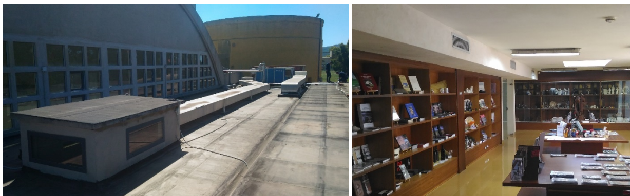
Figura 30. Canalizzazioni esterne e interne di distribuzione dell’aria nella zona commerciale (UTA_1)
