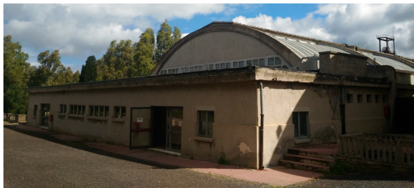
Figura 3. Vista 2 angolo sud-est (bar, uffici)
