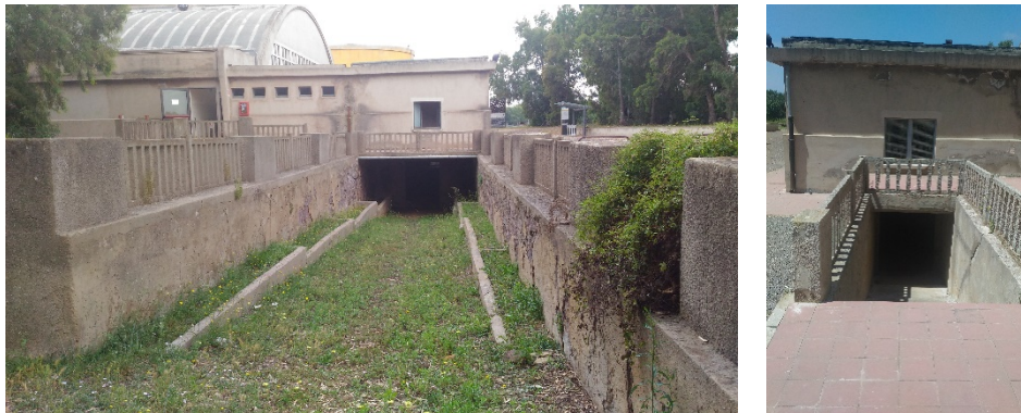
Figure 13. Ingressi del locale seminterrato al di sotto della zona commerciale del CF_B
