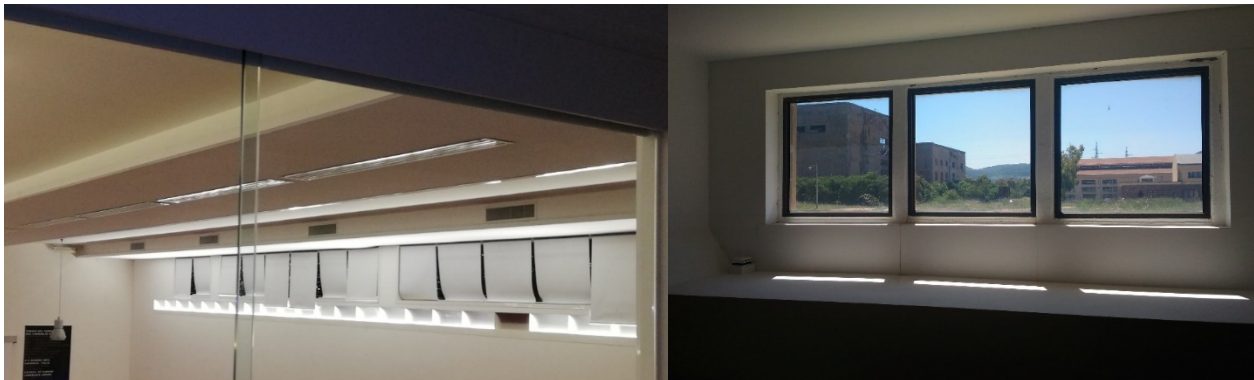
Figura 19. Finestre dell’auditorium (fin_1) con schermatura interna e nell’ingresso della sala conferenza
