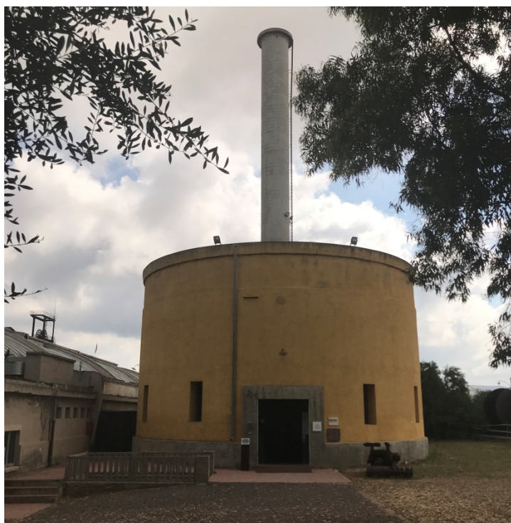
Figura 5.1.4. Ingresso del Museo (ex sala Caldaie)
