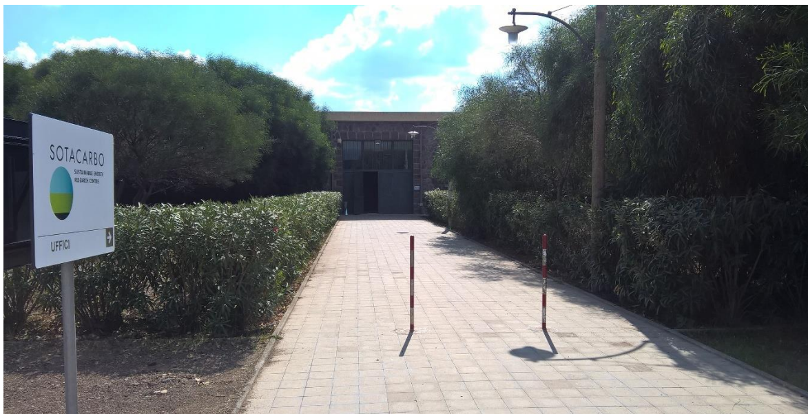
Figura 2.1. Centro Ricerche Sotacarbo (prospetto anteriore).
