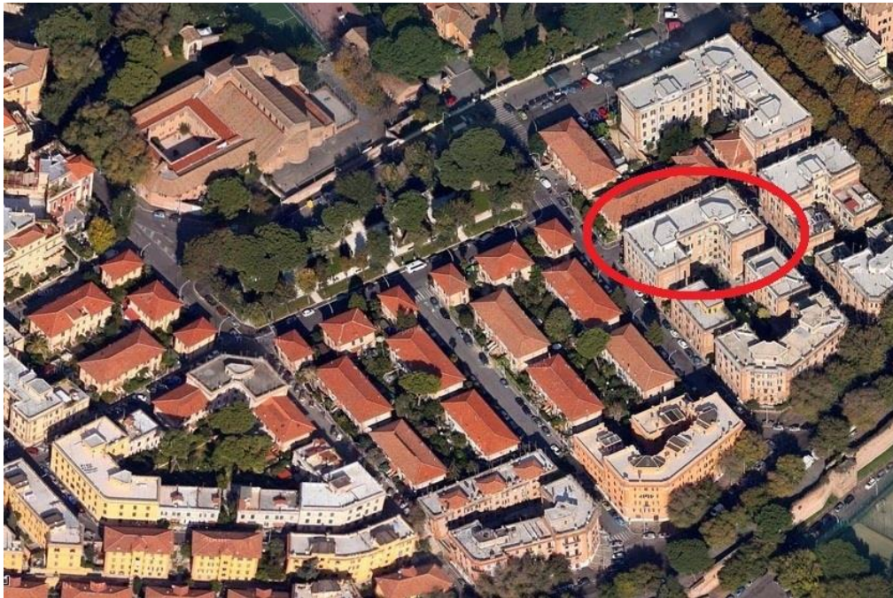
Figura 2: Edificio 7 del Lotto 1
