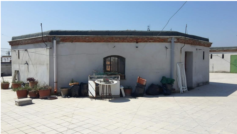
Figura 30 Torrino copertura vano scala condominiale
