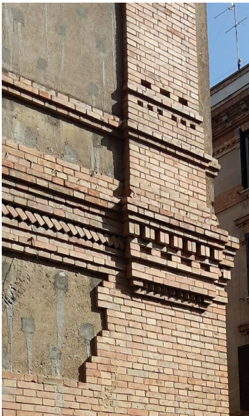
Figura 37 particolare delle specchiature dell'intonaco e le partiture in laterizio sulle facciate dell'edificio
