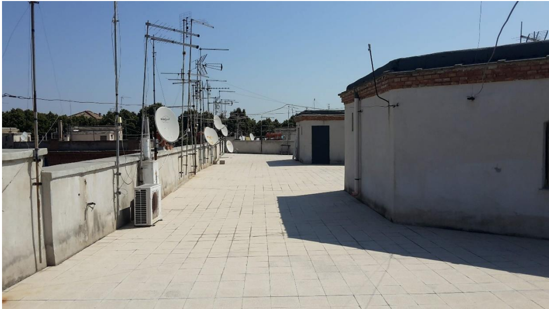
Figura 12 : terrazzo copertura fabbricato 1 con torrini di accesso scale A e B
