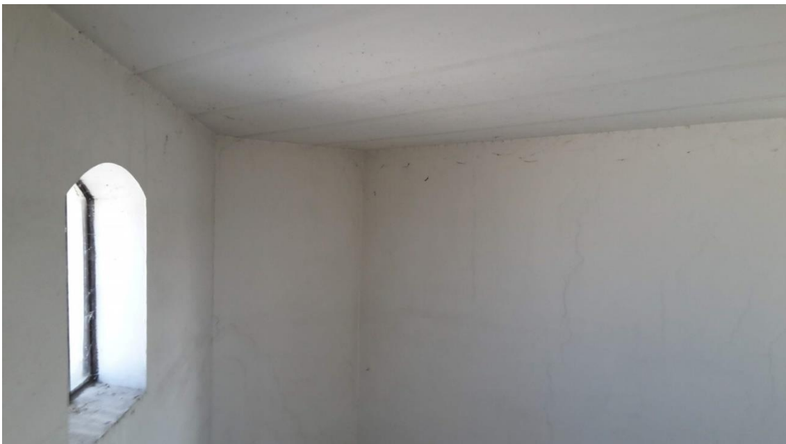
Figura 11: solai copertura androne scale. Si noti l'orditura del solaio con travi in ferro tipiche dell'epoca e delle tecniche costruttive dell'area romana.
