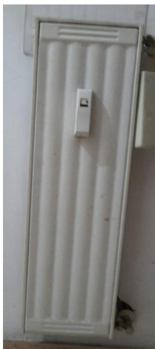
Figura 21: rilievo fotografico di un radiatore a piastre all'interno di un appartamento
