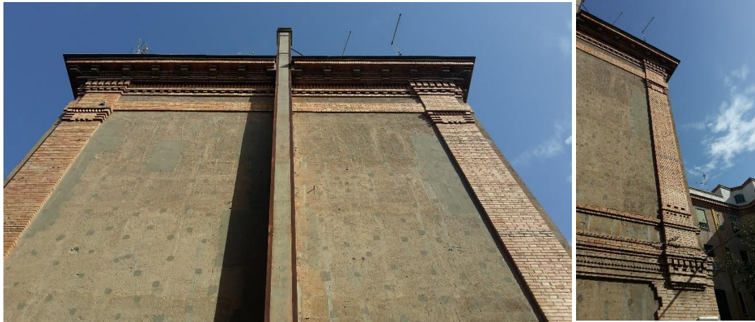
Figura 8: particolare di uno dei prospetti del fabbricato 1 in intonaco e laterizi
