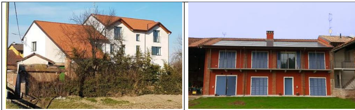
Figura 13 - Ristrutturazioni NZEB a Vespolate e Galliate
