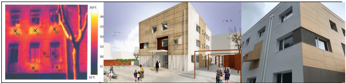
Figura 12 - Municipio di Gabicce Mare: rilievo termografico pre-intervento, progetto e nuova facciata
