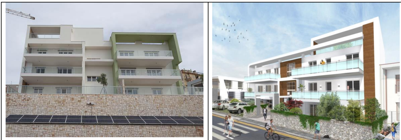
Figura 16 - Putignano: residenza plurifamiliare certificata Passivhaus - tutti gli appartamenti sono nZEB
